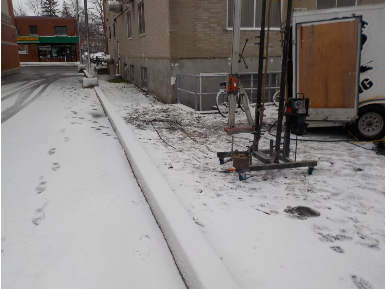
Photographie 1 : Vue du site au niveau du forage 19F01 – 28 novembre 2019
