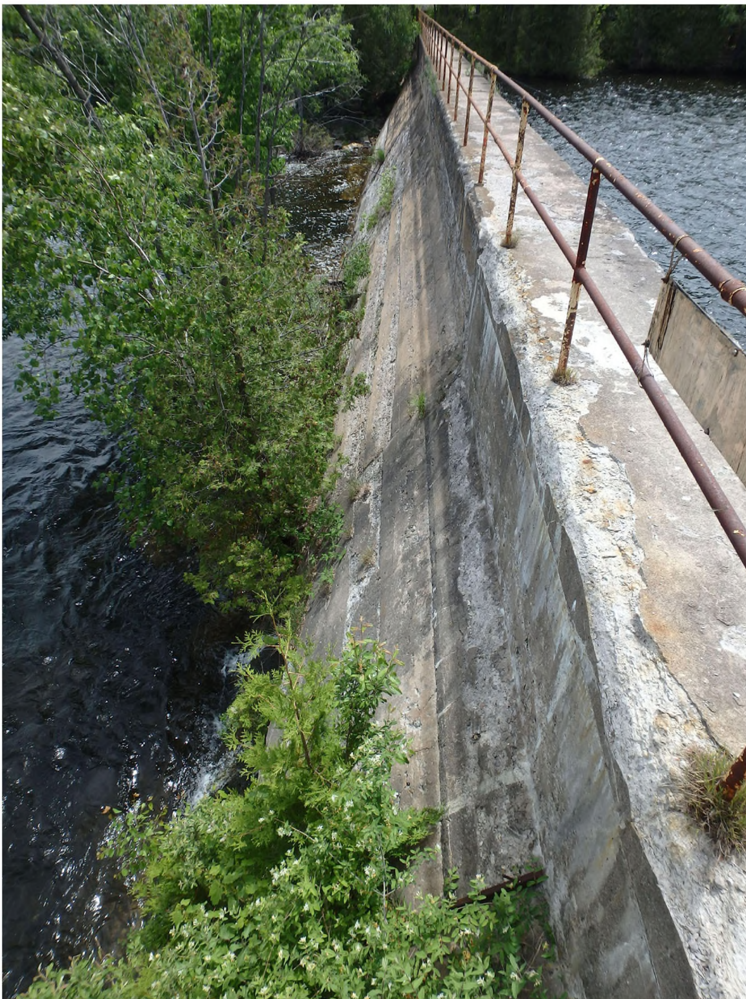
CÔTÉ AVAL DU BARRAGE POIDS SUD EXISTANT
