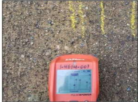
Image 4. Radar à impulsions qui indique la présence d'acier d'armature dans le tablier de béton.
