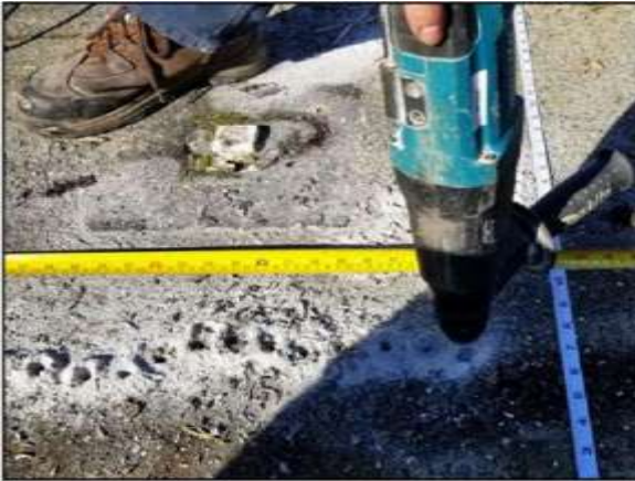
Image 3. Trous d'essai forés pour déterminer l'emplacement des cloisons sous le tablier de béton.
