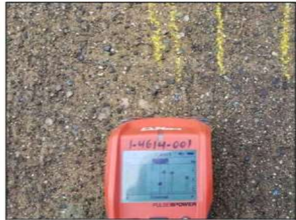
Image 4. Radar à impulsions qui indique la présence d'acier d'armature dans le tablier de béton.
