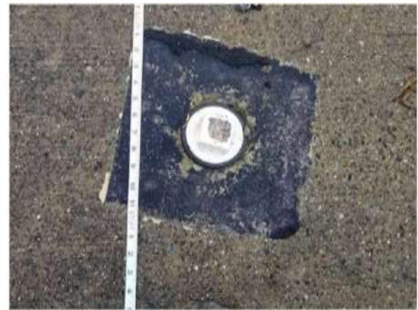
Image 6. Bouchon de tablier en plastique et ensemble de manchons internes dans le tablier.
