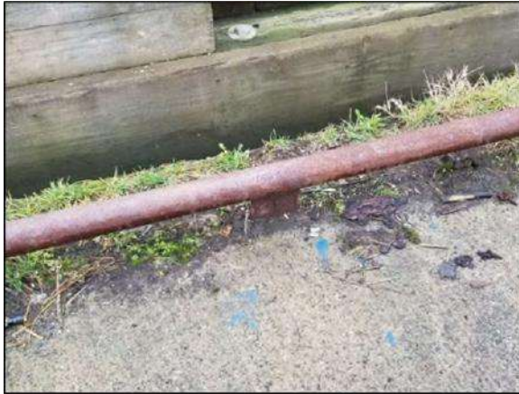
Image 7. Rail d'amarrage en tuyau d'acier soudé à des plaques d'acier encastrées dans le tablier de béton.
