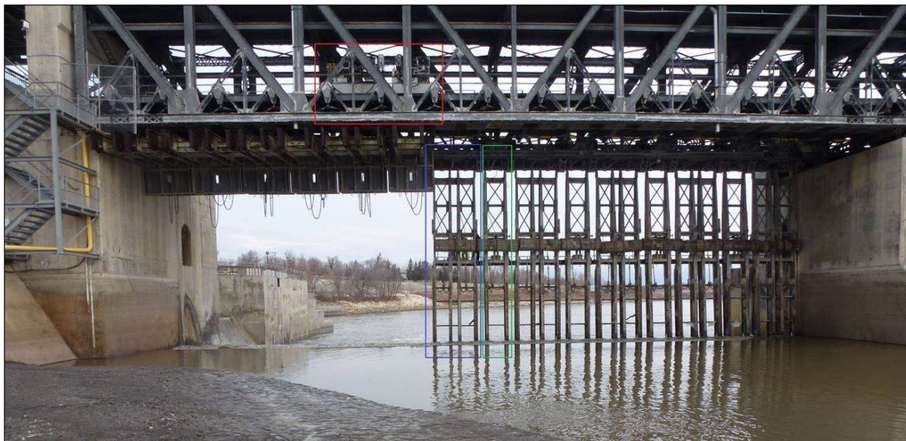
Figure 3: Pertuis montrant les cadres partiellement enlevé à l'automne.
