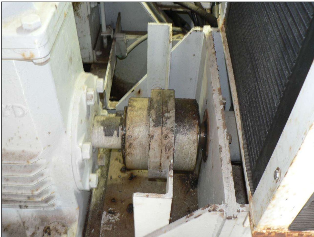
Figure 9: Détail avec la boîte de vitesses à gauge, refroidisseur d'huile à droit, et au centre, l'accouplement de l'arbre menant au moteur
