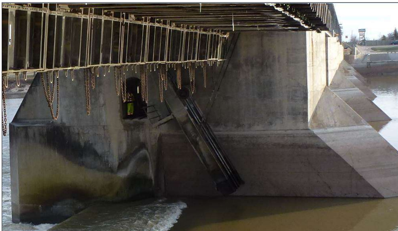
Figure 4: Des cadres en train d'être hissés.
