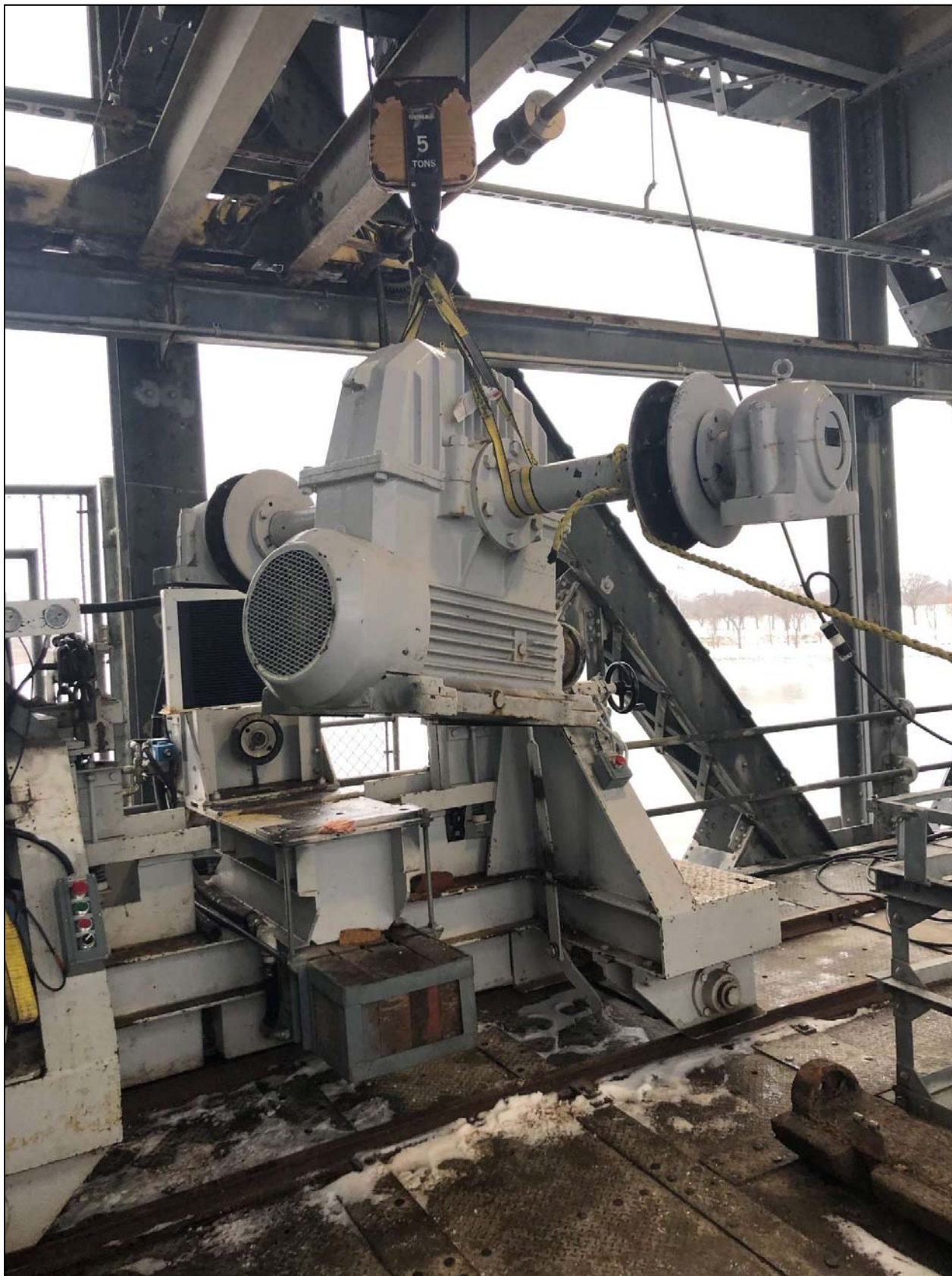
Figure 11: Retrait de la boîte de vitesses en cours durant le projet de révision de la grue à cadre principale.
