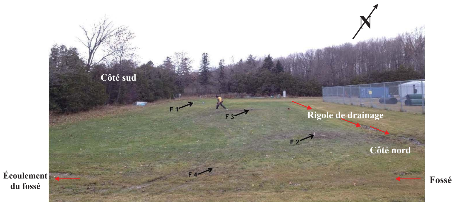
Figure 2-1 : Regardant vers le nord-ouest du terrain à l'étude avec le réservoir d'eau pour incendies du côté sud. Remarquez la faible profondeur de la rigole de drainage des eaux de surface provenant de la cour du chenil au nord.
