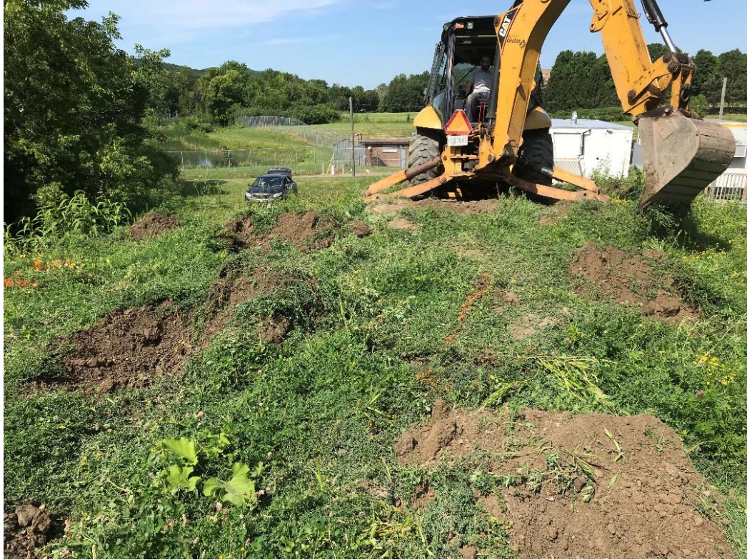
PHOTO 3 — Réalisation de saignées dans l'empilement de sol EMP-1.
