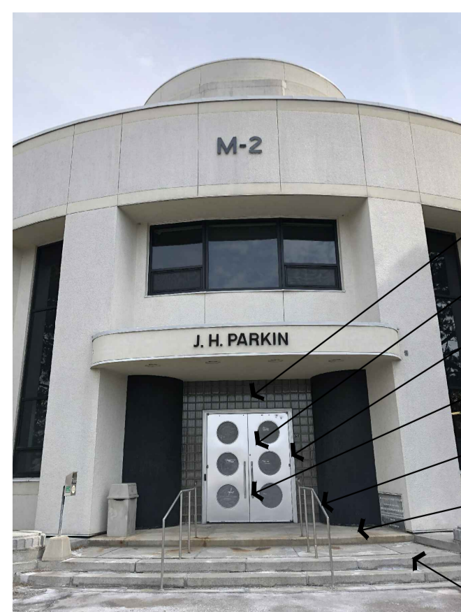
9 ÉLÉMENTS EXISTANTS À L'ENTRÉE PRINCIPALE A01 ÉCHELLE = AUCUNE
