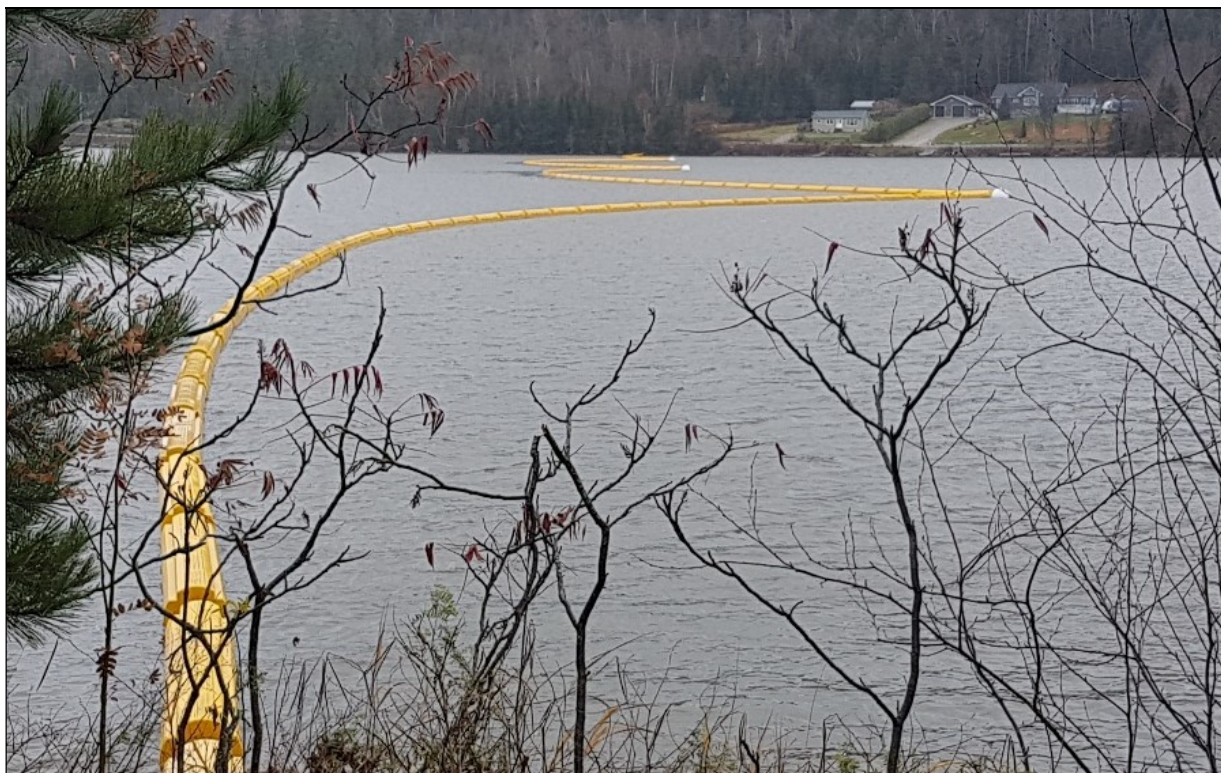
Figure 3 - Barrière de voie navigable au barrage Timiskaming, vue depuis la rive québécoise
