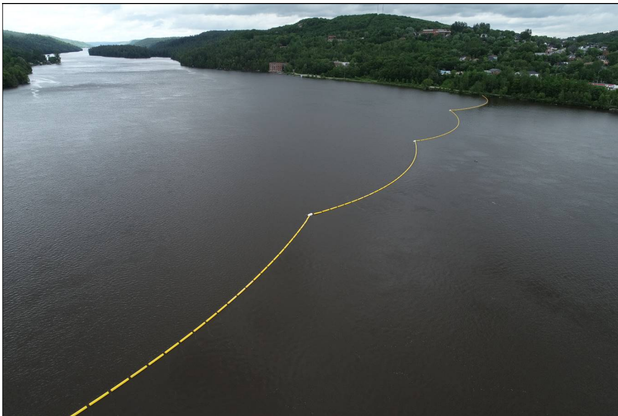
Figure 2 - Barrière de voie navigable au barrage Timiskaming, vue aérienne vers l'amont du barrage
