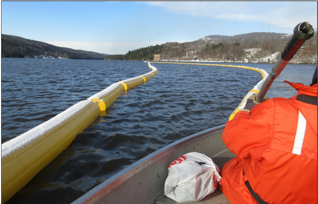
Figure 4 - Des gardiens de barrage manipulant la barrière de voie navigable au barrage Timiskaming
