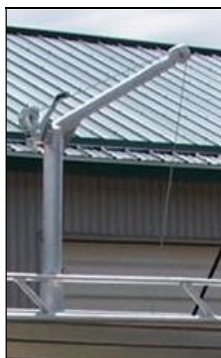
Figure 9 - Exemple de la configuration générale souhaitée pour le bossoir
