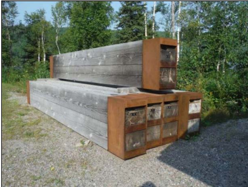
Figure 16 : Poutrelles doubles (de rechange) destinées au barrage du Québec, sans rallonge à l'extrémité du capuchon. Photo MMM 2014.
