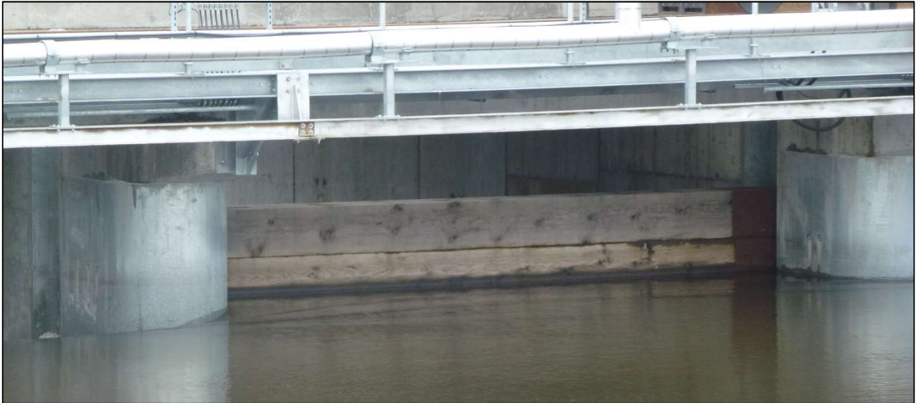
Figure 21 : Vue en amont des poutrelles à l'intérieur d'un pertuis du barrage de l'Ontario.
