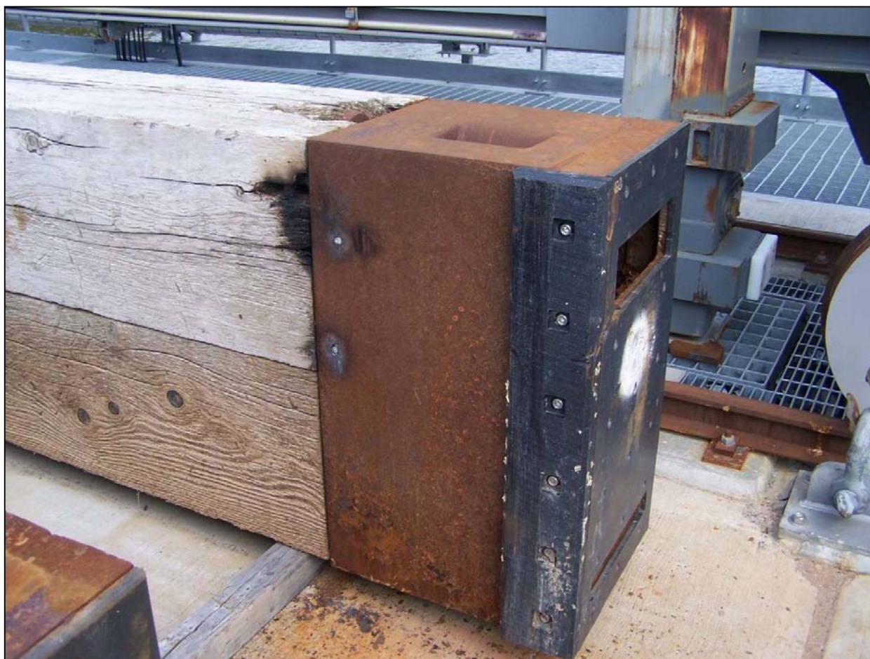
Figure 14 : Poutrelle double du barrage de l'Ontario munie d'une rallonge à l'extrémité du capuchon
