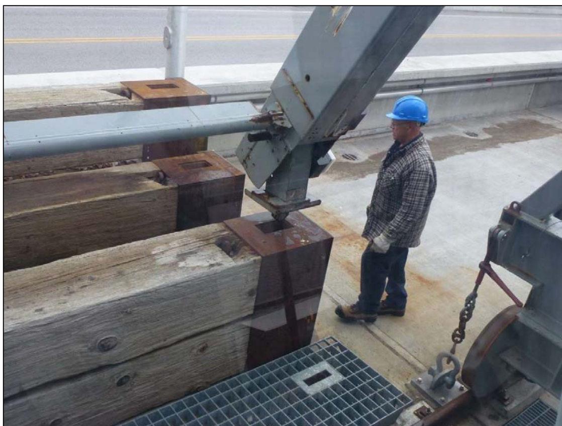
Figure 12 : Lève-poutrelles se préparant à soulever une poutrelle de la passerelle. Remarquer le couvercle des pertuis qui, après qu'on l'ait retiré, a été placé sur la passerelle du barrage pendant la durée de l'opération.
