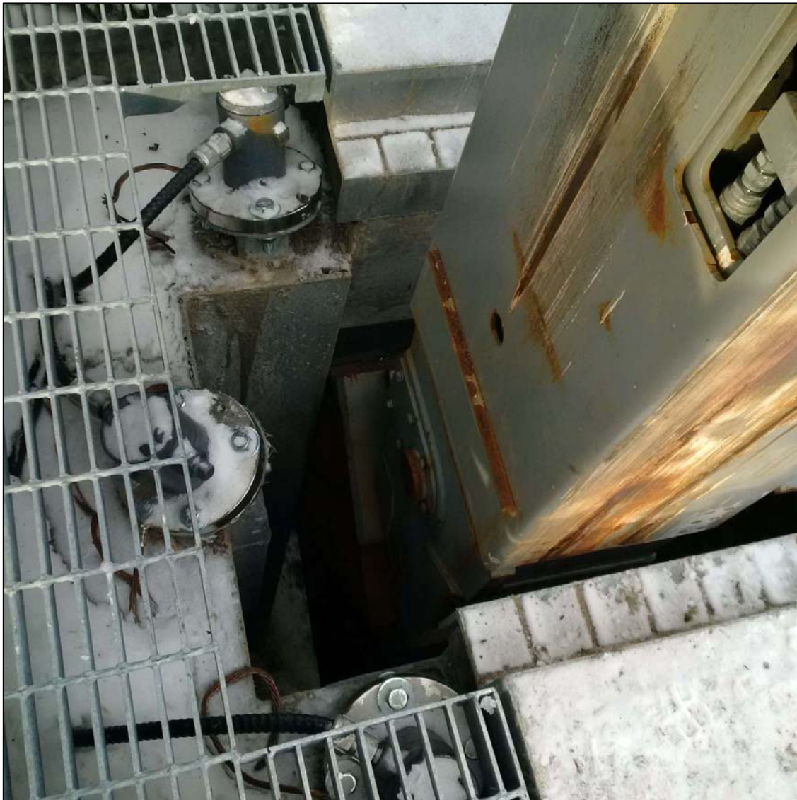
Figure 19 : Les rainures de poutrelle au barrage de l'Ontario présentent des dispositifs de chauffage qui nuisent légèrement aux mouvements des poutrelles.
