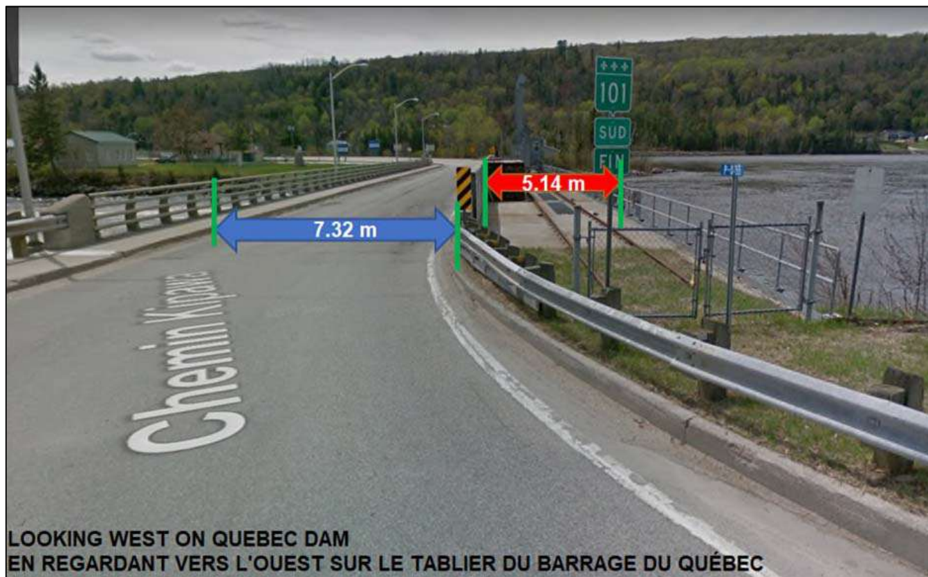
Figure 6 : Largeur des tabliers sur le barrage du Québec.
