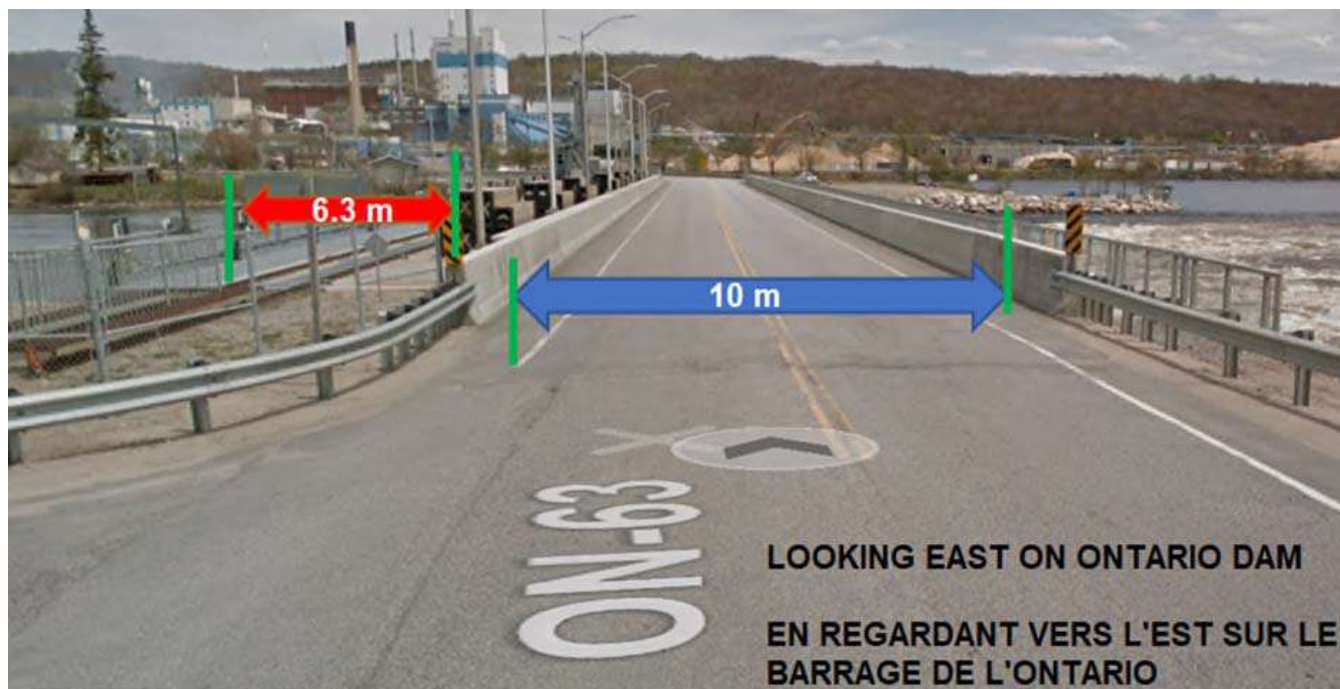
Figure 5 : Largeur des tabliers sur le barrage de l'Ontario.
