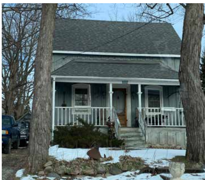
Une galerie surmontée d'un long avant-toit protégeant contre les intempéries
