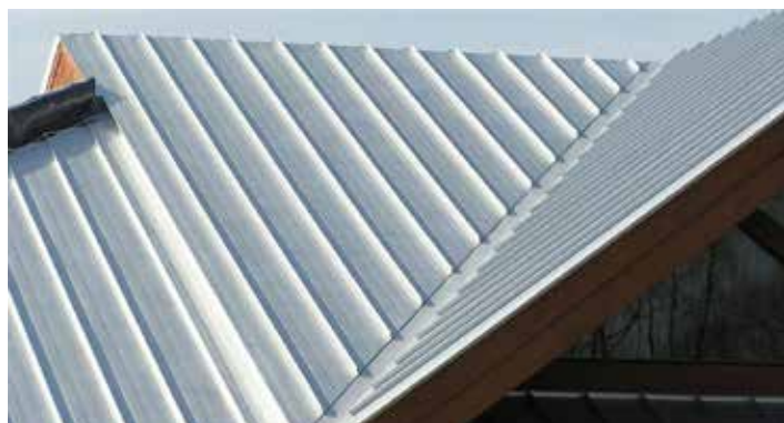
Toiture métallique à joints debout
