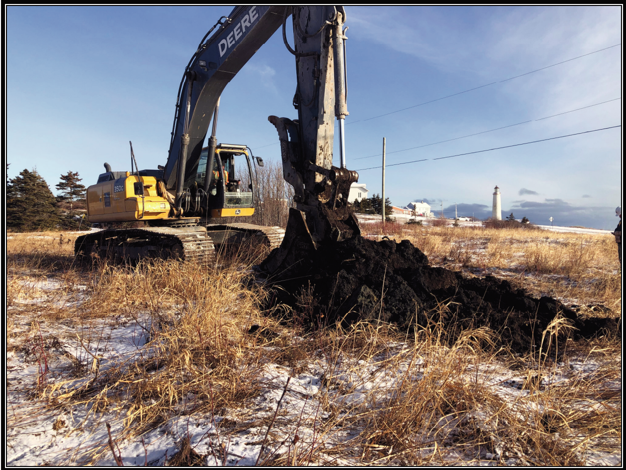
Photo 5 : Emplacement du puits d'exploration PU-03-19.
