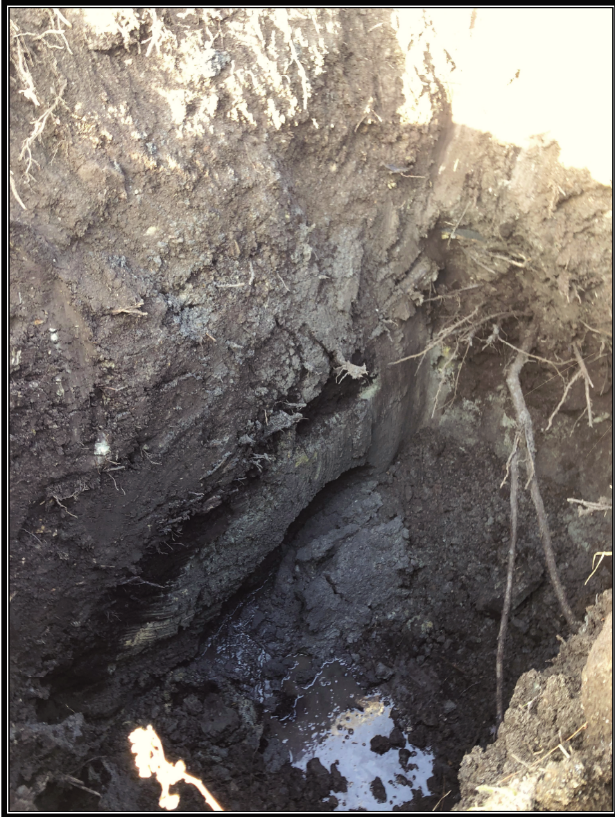
Photo 4 : Paroi du PU-02-19.
