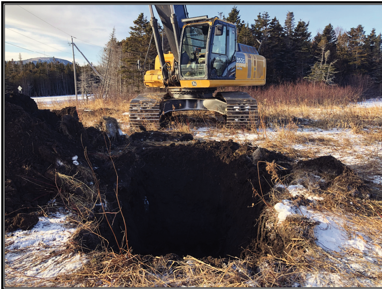
Photo 7 : Emplacement du puits d'exploration PU-04-19.
