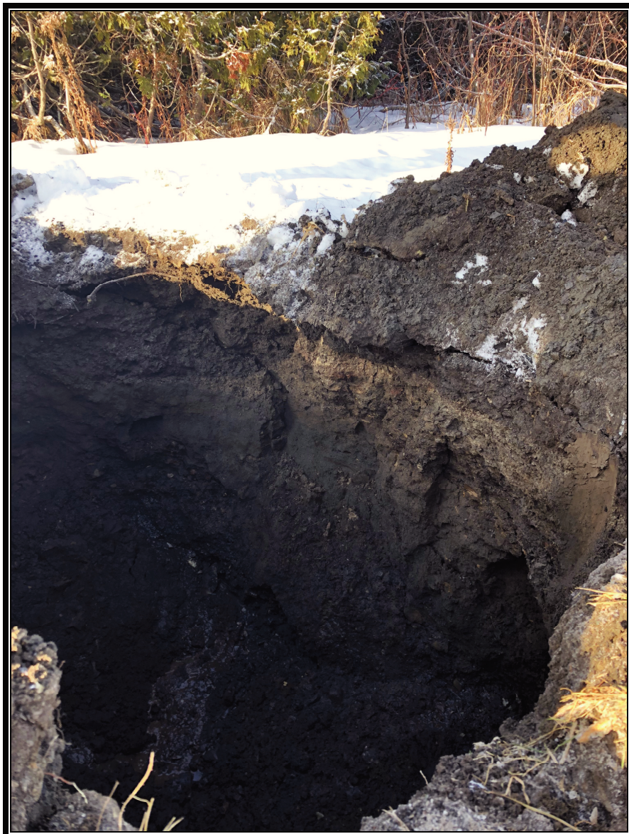
Photo 2 : Paroi du PU-01-19.
