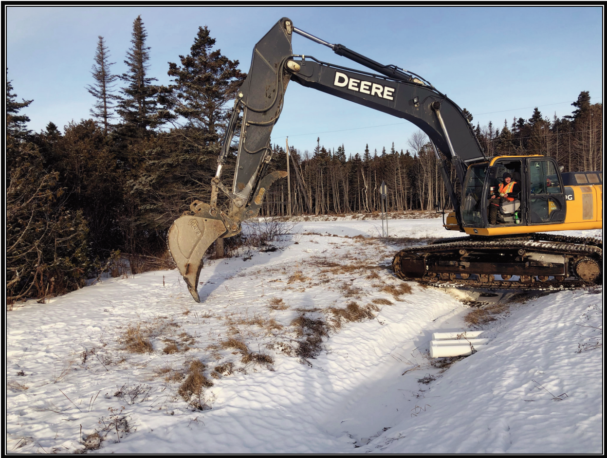
Photo 1 : Emplacement du puits d'exploration PU-01-19.
