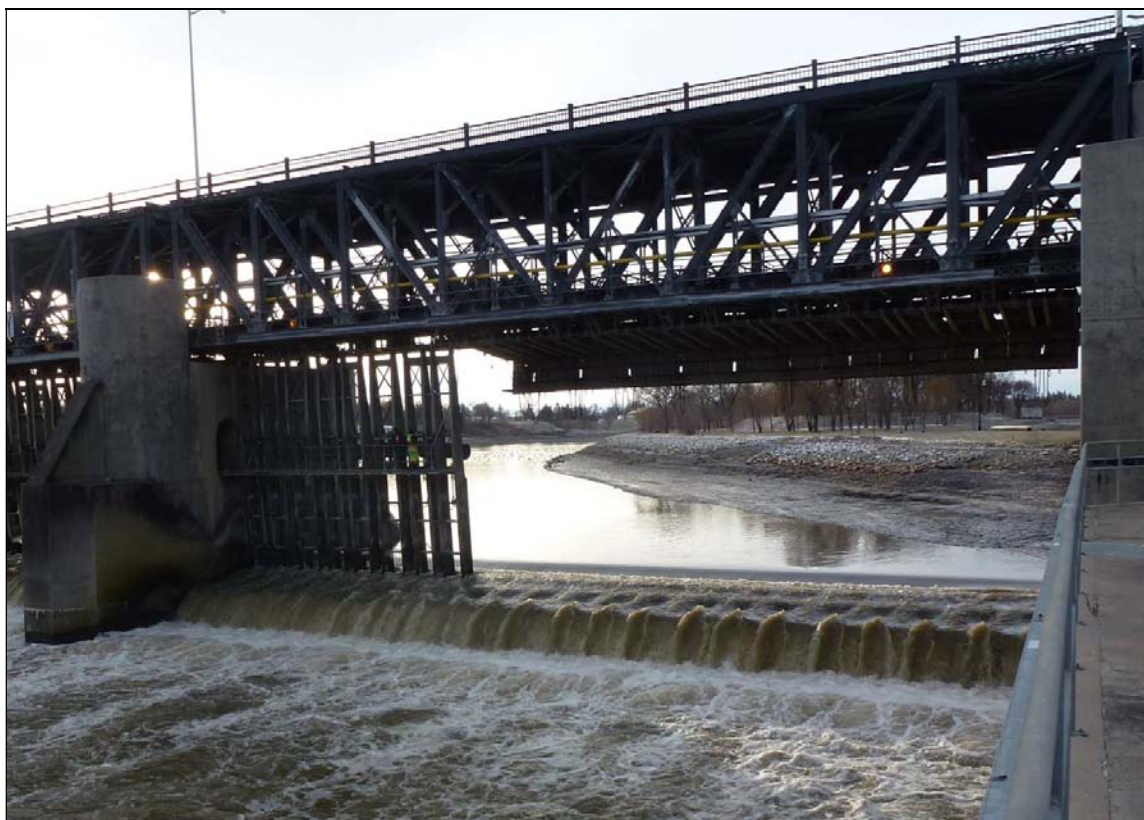
Figure 7 : Détail du barrage illustrant une baie dont les cadres sont levés pour l'hiver.
