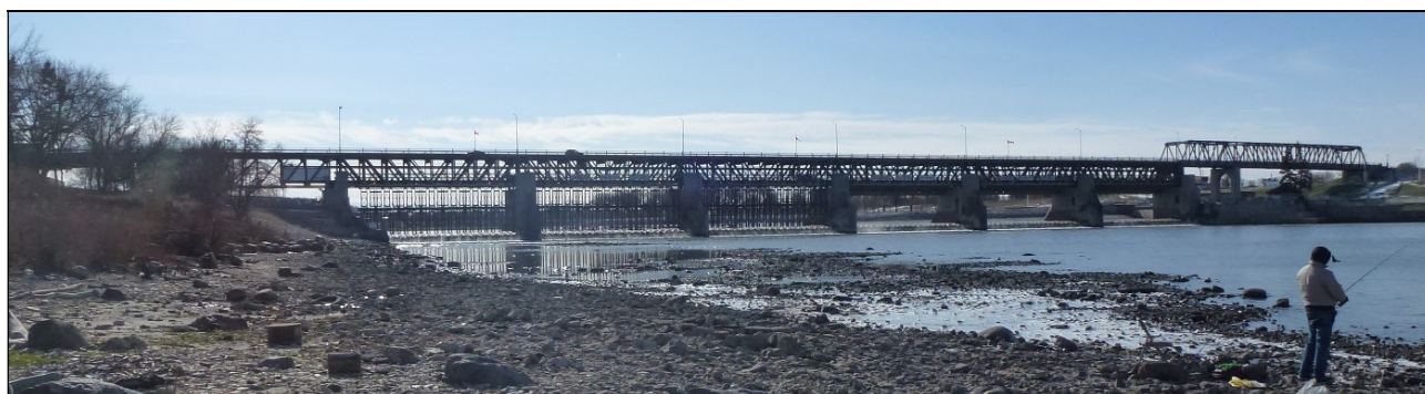
Figure 3 : Vue en aval (côté nord) de l'écluse et barrage St. Andrew's. Les rideaux ont été retirés à gauche, et les cadres sont levés à droite.
