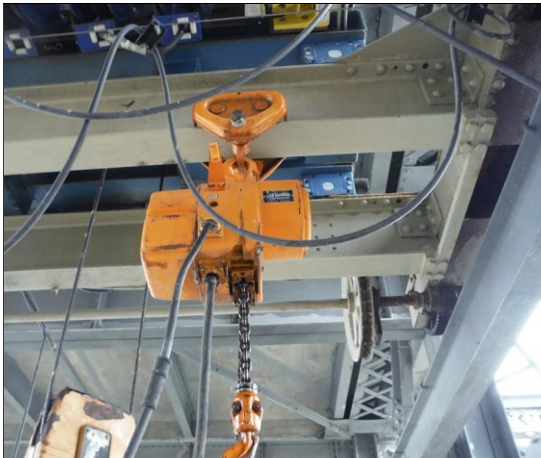
Figure 29 : Pont roulant bipoutre sur le tablier opérationnel, détail du treuil à chaîne de 1 tonne et sommier.
