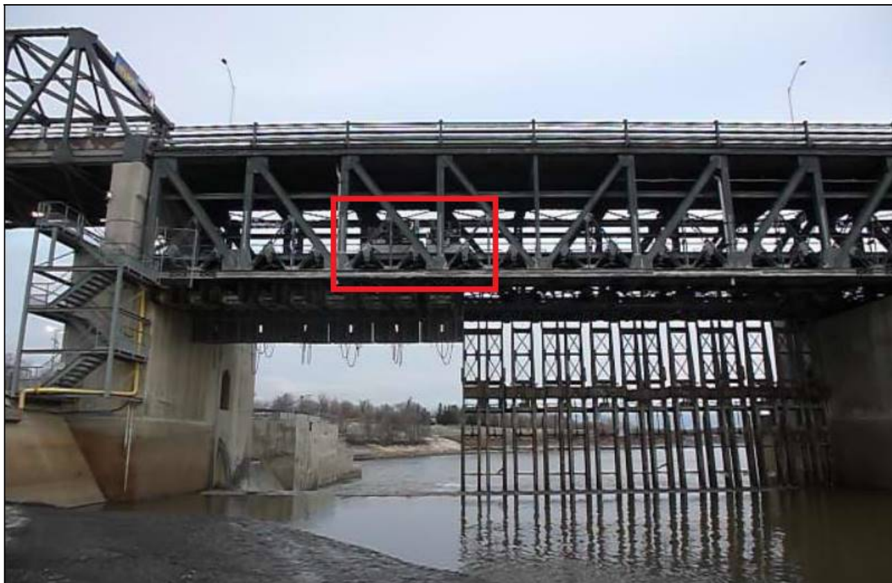
Figure 9 : Grue à cadres principale (dans le rectangle rouge) sur le tablier opérationnel. En regardant vers l'aval. Les cadres sont en train d'être levés pour l'hiver.
