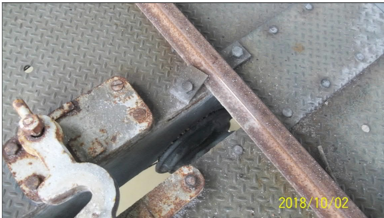
Figure 17 : Le guide de poulie à chaîne au tablier du barrage semble être obstrué par du gravier.
