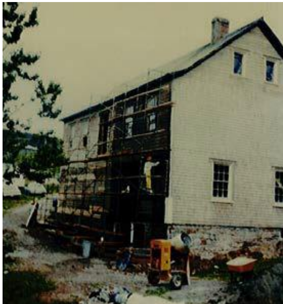
Photo 2 : Travaux de réhabilitation, 1983-1984 (dossier149-09- PR 4.015)
