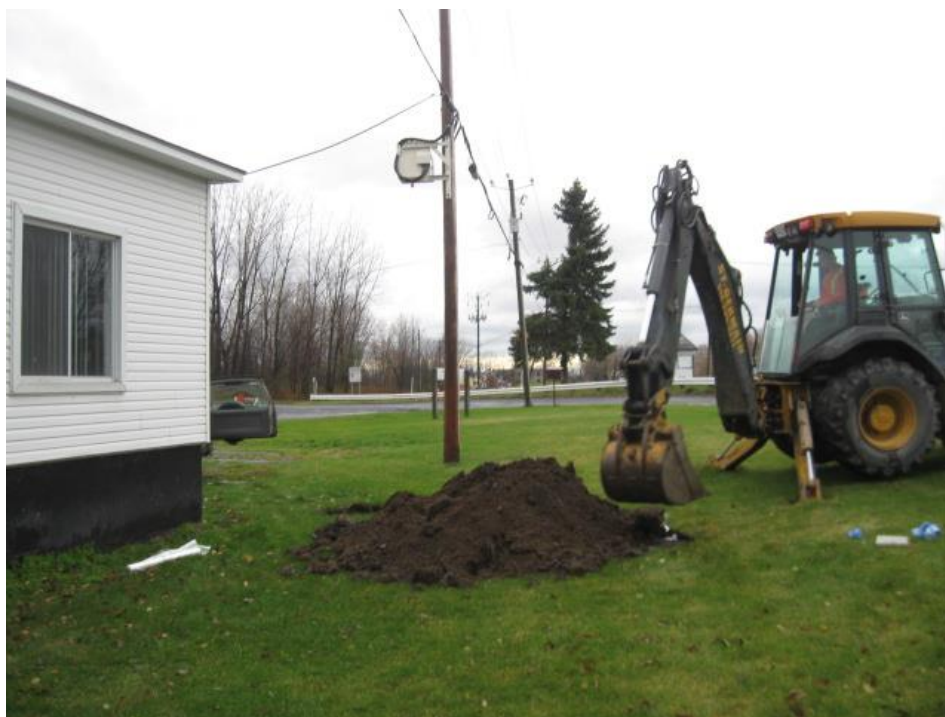
Photographie 14 : Vue vers le sud-est de la réalisation du sondage TE5 du secteur 3.
