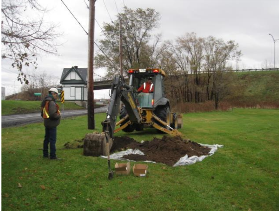
Photographie 15 : Vue vers le nord-est de la réalisation du sondage TE6 du secteur 3.
