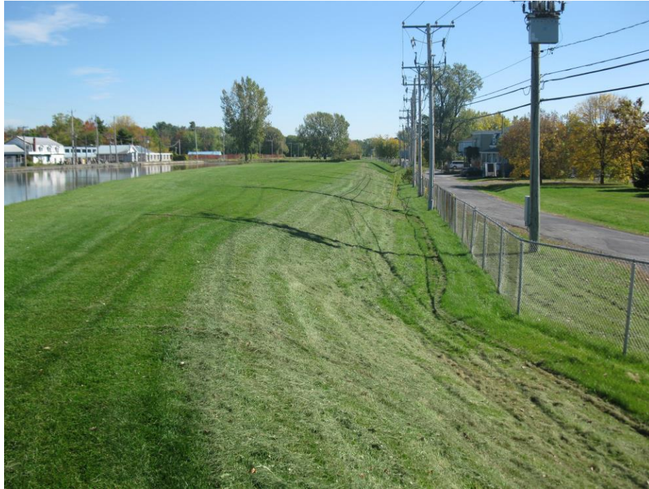
Photographie 1 : Vue vers le sud-est du secteur 1.
