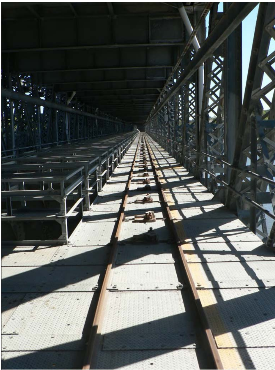
Figure 4: Operating deck showing crane rails for frame crane / / / Tablier opérationnel montrant le rail de grue pour la grue à cadres
