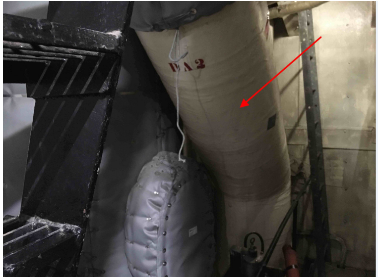
A107 Tuvauterie Échappement — Génératrice — Irrégulière et rectiligne — Magnésie +canevas+pâte cimentaire 33 po — 10 m lin — Embarcations — Salle des machines — 409 — N/A Alexandre.Caza 2017-06-29 13:12
