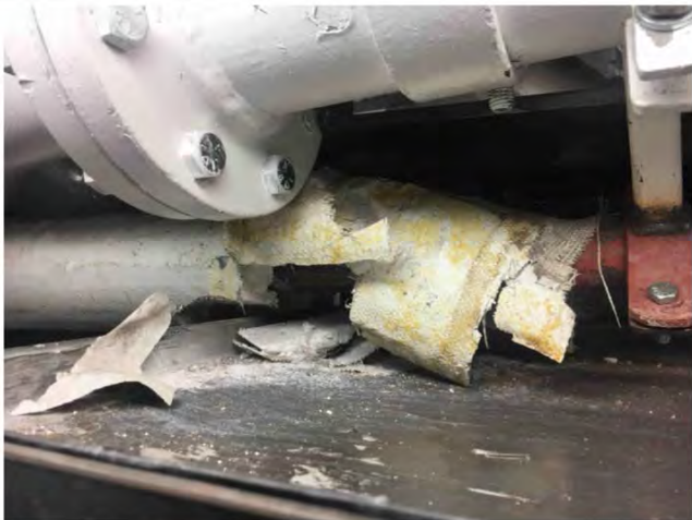
13 Tuyauterie Vapeur (alimentation) — Rectiligne — Magnésie — 5 po. — 35 m. lin. — Salle des propulseurs — Salle des propulseurs — 0 — Pastille 5 Chantal.Soulard - 2019-11-22 09:18
