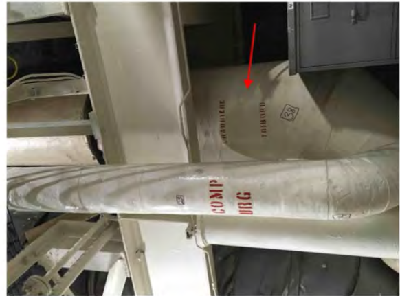
38 Tuyauterie Échappement — Chaudière tribord — Irrégulière et rectiligne — Pâte cimentaire, magnésie et canevas — 22 po. — 28 m. lin. — Supérieur — Salle des machines — 0 — N/A Alexandre.Caza - 2017-06-28 15:28
