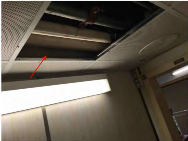
47 Tuyauterie Vapeur (alimentation) — Rectiligne — Magnésie — 5 po. — 1 m. lin. — Principal — Corridor — 0 — Pastille 5 Alexandre.Caza - 2017-06-28 16:06
