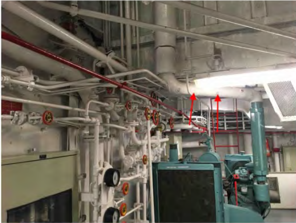
23 Tuyauterie Échappement — Moteur — Rectiligne — Magnésie — 5 po. — 2 m. lin. — Salle des moteurs — Salle des moteurs 17pi — 0 — N/A Alexandre.Caza - 2017-06-28 13:33
