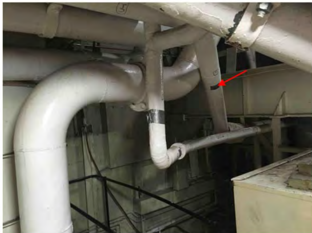
99 Tuyauterie Vapeur (alimentation) — Rectiligne — Magnésie — 5 po. — 0 m. lin. — Supérieur — Salle des machines — 0 — Pastille 5 Alexandre.Caza - 2017-06-29 12:04
