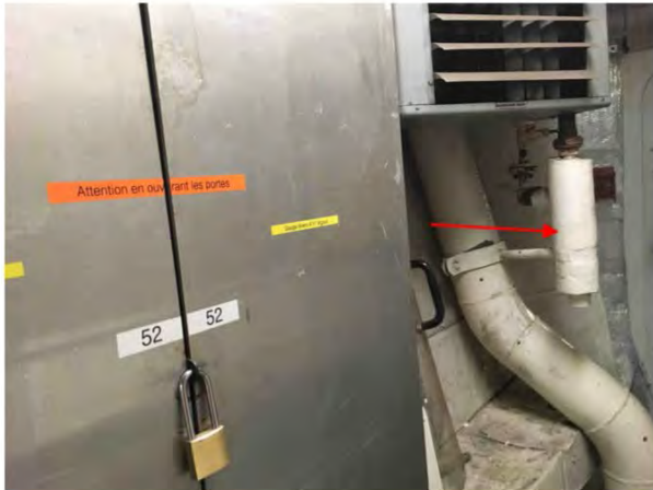
67 Tuyauterie Vapeur (alimentation) — Rectiligne — Magnésie — 5 po. — 20,5 m. lin. — Principal — Pont arrière — 689 — Pastille 5 Alexandre.Caza - 2017-06-29 08:22
