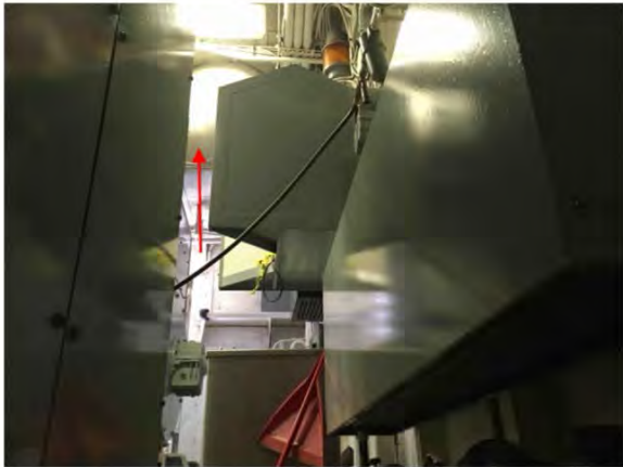
Tuyauterie Échappement — Génératrice d'urgence — Irrégulière et rectiligne — Canevas et magnésie — 22 po. — 12 m. lin. — Officiers — Salle des génératrices — 319 — N/A Alexandre.Caza - 2017-06-29 12:58
