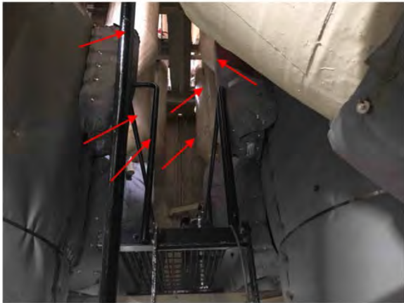
108 Tuyauterie Échappement — Moteur — Irrégulière et rectiligne — Canevas+pâte cimentaire +magnésie — 33 po. — 72 m. lin. — Officiers — Salle des cheminées — 0 — Pastille 107 Alexandre.Caza - 2017-06-29 13:16
