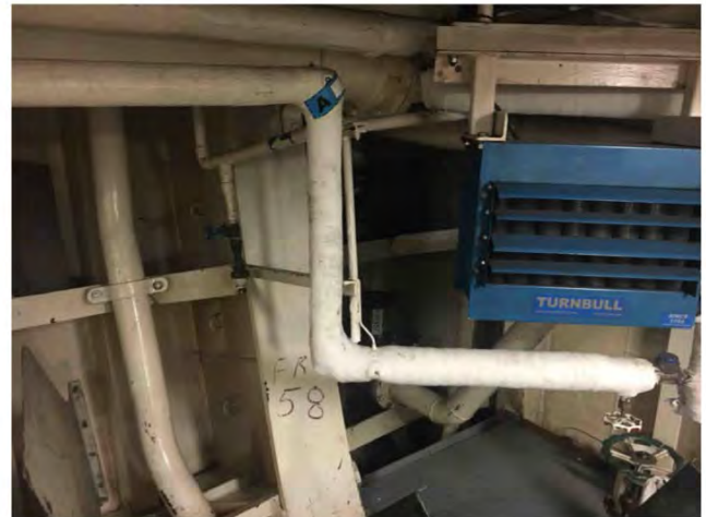
8 Tuyauterie Vapeur (alimentation) — Irrégulière — Canevas et pâte cimentaire — 4 po. — 6 unité — Salle des propulseurs — Salle des propulseurs — 0 — N/A Chantal.Soulard - 2019-11-22 09:20
