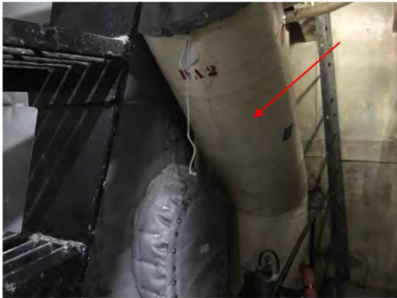
119 Tuyauterie Échappement — Génératrice — Irrégulière et rectiligne — Magnésie +canevas+pâte cimentaire — 33 po. — 0 m. lin. — Navigation — Accès salle des machines — 211 — Pastille 107 Alexandre.Caza - 2017-06-30 09:00
