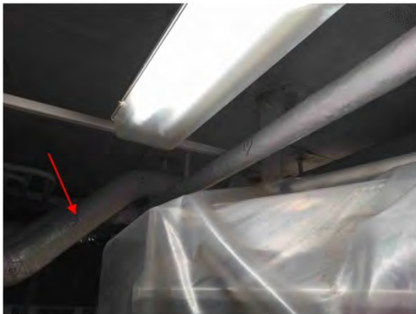
116 Tuyauterie Vapeur (alimentation) — Rectiligne — Magnésie — 5 po. — 0 m. lin. — Principal — Pont arrière — 689 — Pastille 5 Alexandre.Caza - 2017-06-29 15:13
