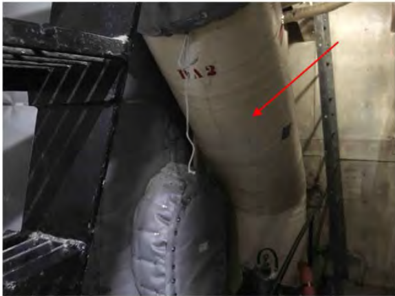
107 Tuyauterie Échappement — Génératrice — Irrégulière et rectiligne — Magnésie +canevas+pâte cimentaire — 33 po. — 10 m. lin. — Embarcations — Salle des machines — 409 — N/A Alexandre.Caza - 2017-06-29 13:12
