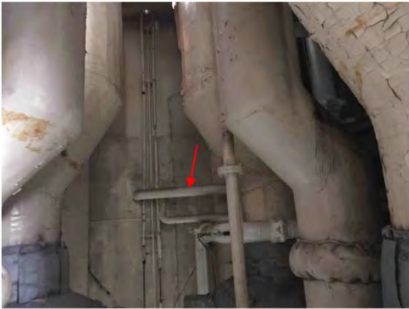
110 Tuyauterie Vapeur (alimentation) — Rectiligne — Magnésie — 5 po. — 3 m. lin. — Officiers — Salle des cheminées — 0 — Pastille 5 Alexandre.Caza - 2017-06-29 13:21
