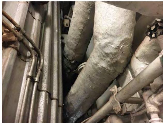
41 Tuyauterie Vapeur (alimentation) — Rectiligne — Magnésie — 5 po. — 4 m. lin. — Supérieur — Salle des machines — 0 — Pastille 5 Chantal.Soulard - 2019-11-22 09:17
