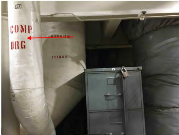
36 Tuyauterie Échappement — Moteur — Rectiligne — Magnésie — 5 po. — 2 m. lin. — Supérieur — Salle des machines — 0 — Pastille 23 Alexandre.Caza - 2017-06-28 15:22
