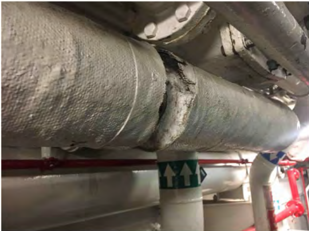
21 Tuyauterie Vapeur (alimentation) — Rectiligne — Magnésie — 5 po. — 45 m. lin. — Salle des moteurs — Salle des moteurs — 0 — Pastille 5 Chantal.Soulard - 2019-11-22 09:17
