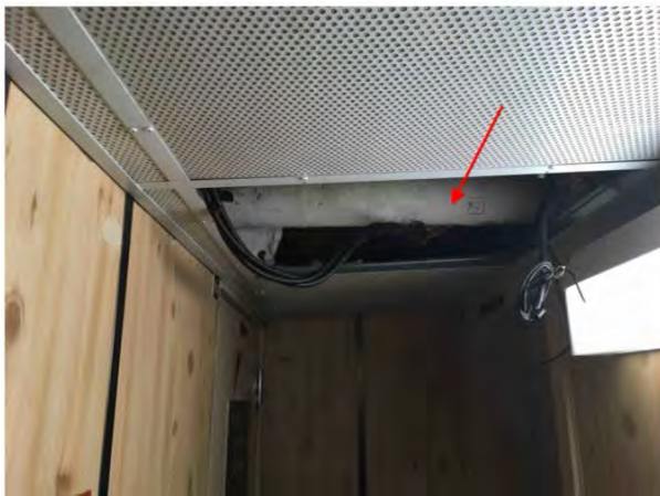
81 Tuyauterie Vapeur (alimentation) — Rectiligne — Magnésie — 5 po. — 1 m. lin. — Supérieur — Salle des machines — 517 — Pastille 5 Alexandre.Caza - 2017-06-29 09:36
