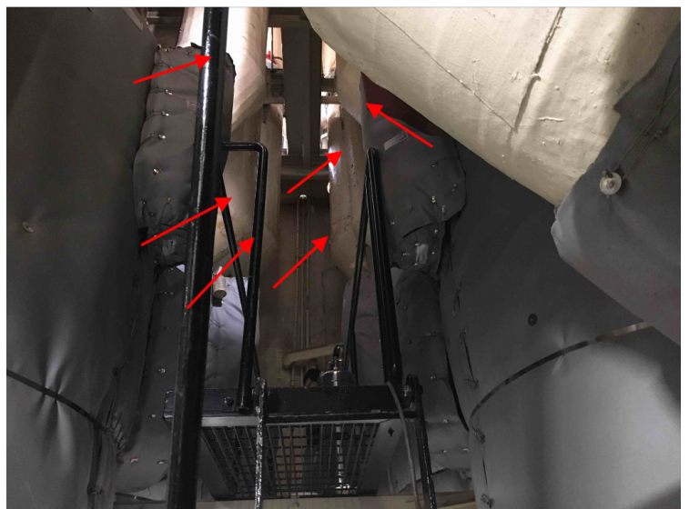
A108 Tuvauterie Échappement — Moteur — Irrégulière et rectiligne — Canevas+pâte cimentaire +magnésie — 33 po — 10 m lin — Embarcations — Salle des cheminées — 0 — Pastille 107 Alexandre.Caza 2017-06-29 13:16
