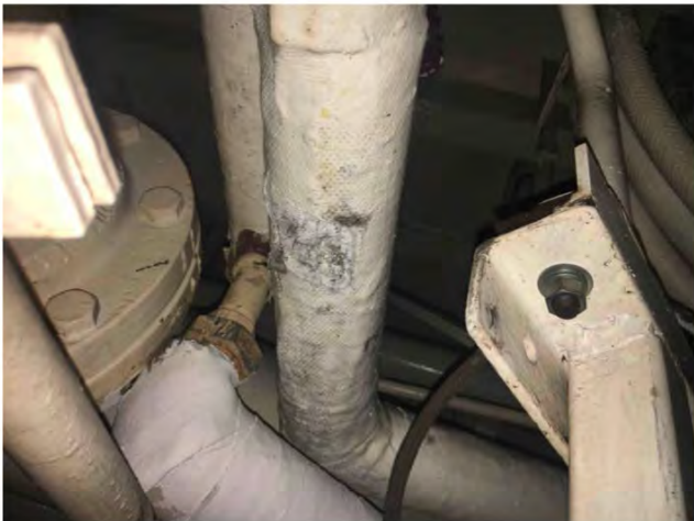
5 Tuyauterie Vapeur (alimentation) — Rectiligne — Magnésie — 5 po. — 9 m. lin. — Salle des propulseurs — Salle des propulseurs — 0 — N/A Chantal.Soulard - 2019-11-22 08:56
