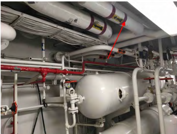
28 Tuyauterie Vapeur (alimentation) — Rectiligne — Magnésie — 5 po. — 4 m. lin. — Salle des moteurs — Salle des moteurs 17pi — 0 — Pastille 5 Alexandre.Caza - 2017-06-28 14:16
