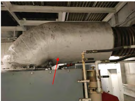
34 Tuyauterie Échappement — Incinérateur — Irrégulière et rectiligne — Canevas et pâte cimentaire et magnésie — 22 po. — 16 m. lin. — Principal — Incinérateur — 642 — N/A Alexandre.Caza - 2017-06-30 08:34
