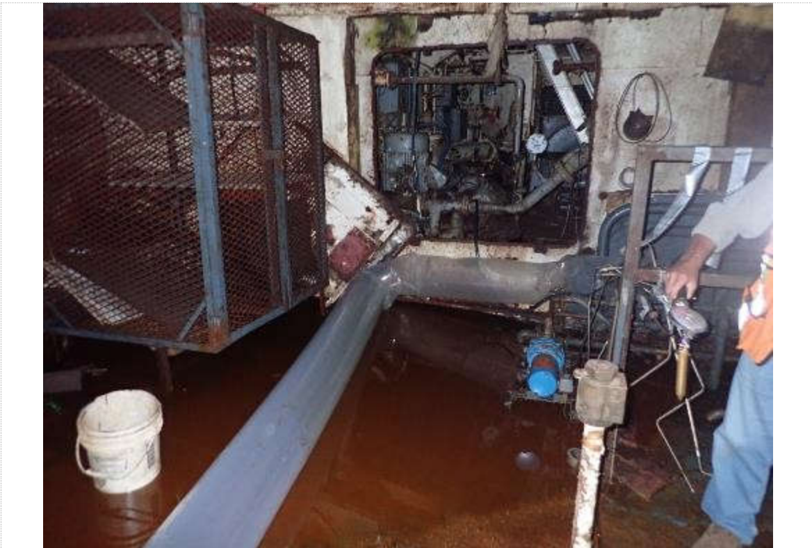
26. Cloison entre le compartiment de mélange des gaz et la salle de propulsion principale coupée et ouverte
