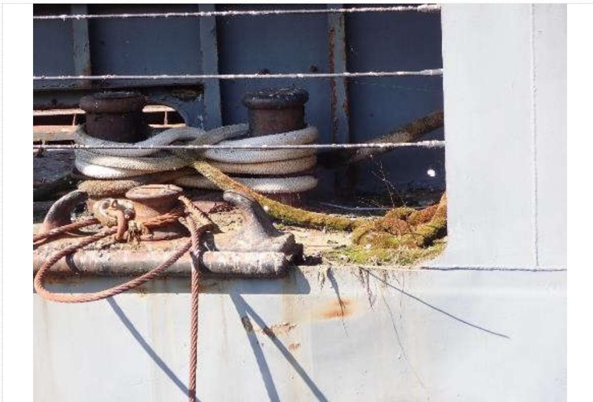
10. État général des amarres et des câbles métalliques
