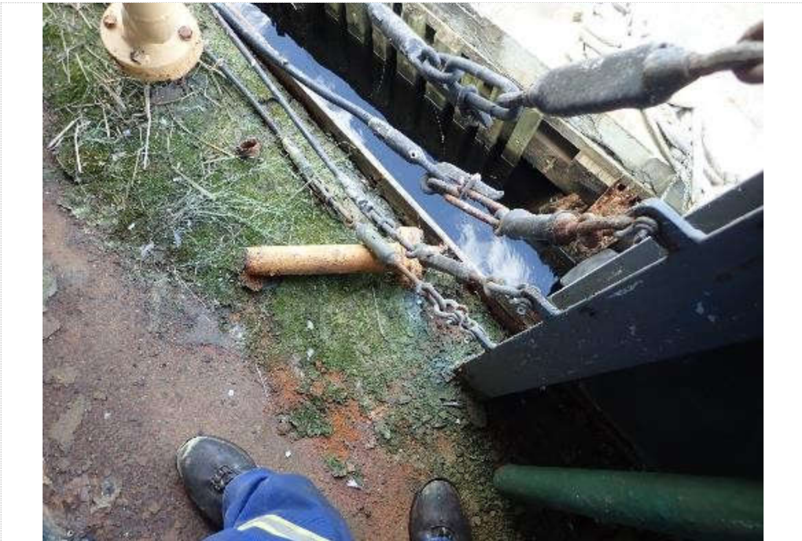
18. Tuyau de sondage brisé sur le réservoir de mazout de tribord n° 13
