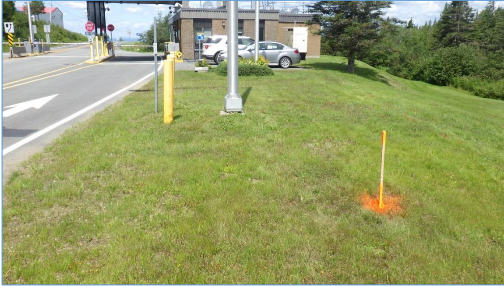
Photo 9 : Visée nord-est – Localisation du nouveau puits projeté au poste de Chartierville.
