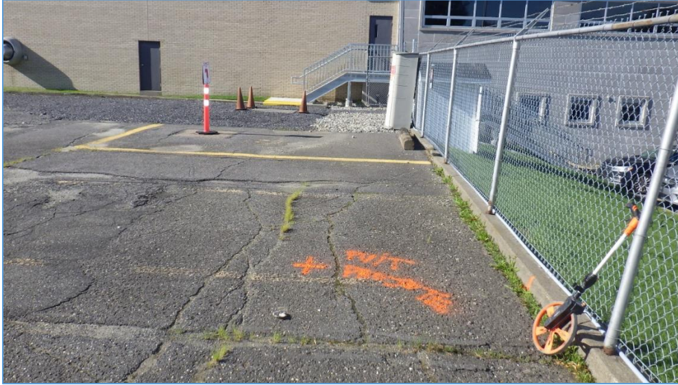
Photo 15 : Localisation du nouveau puits projeté au poste de Stanhope.
