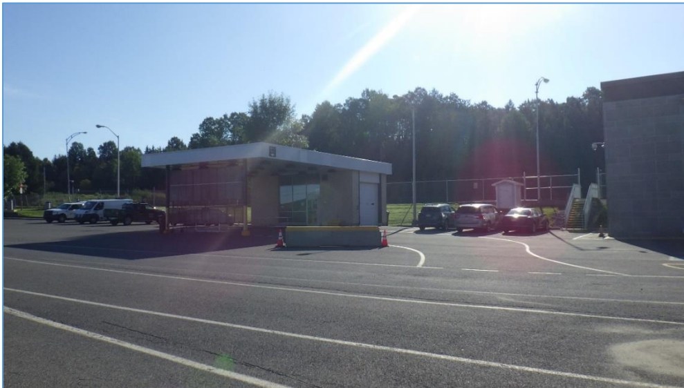
Photo 12 : Visée est - Localisation du cabanon à remblayer après la connexion du nouveau puits au poste de Stanhope.
