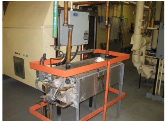
Humidifier (AHU) - Replace
