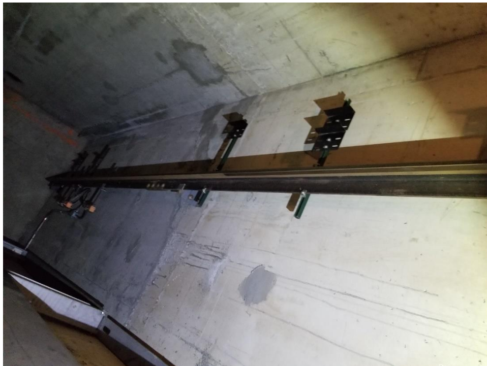
Photo 1 : Les plaques de crépi à base de ciment dans la cage de l'ascenseur ne contiennent pas d'amiante.
