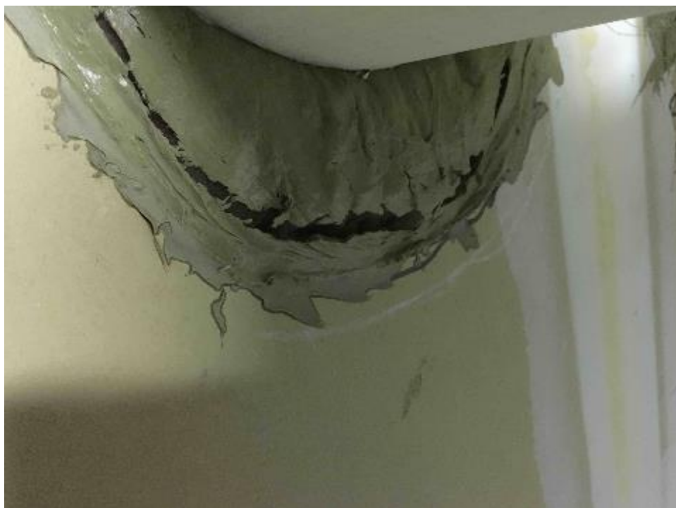
PHOTO 4 Le mastic brun présent dans l'entreplafond du local B-129 ne contient pas d'amiante
