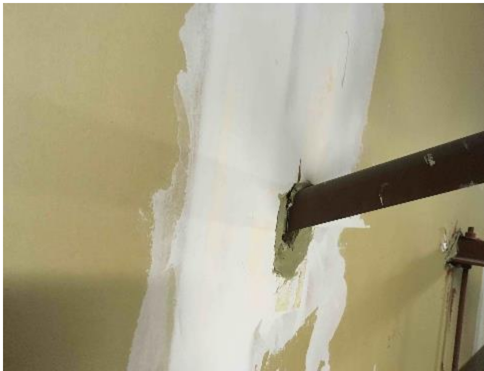
PHOTO 3 Le mastic brun présent dans l'entreplafond du local B-129 ne contient pas d'amiante
