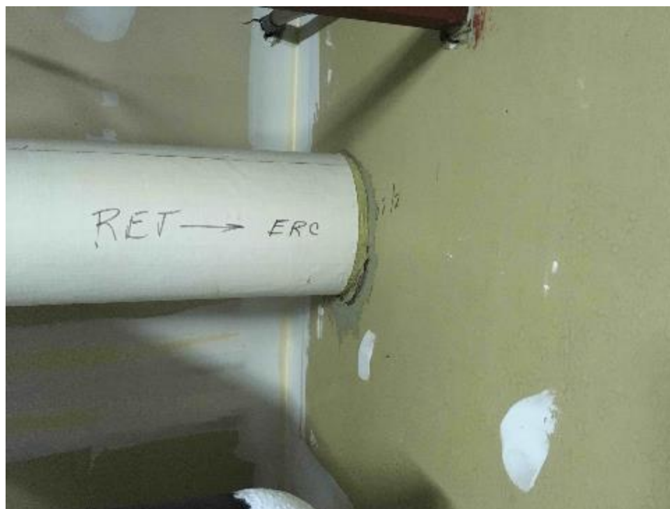
PHOTO 2 Le mastic brun présent dans l'entreplafond du local B-129 ne contient pas d'amiante
