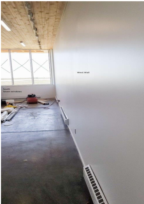
Photo 12 : Pavillon – Vue sur le sud le long du mur ouest
