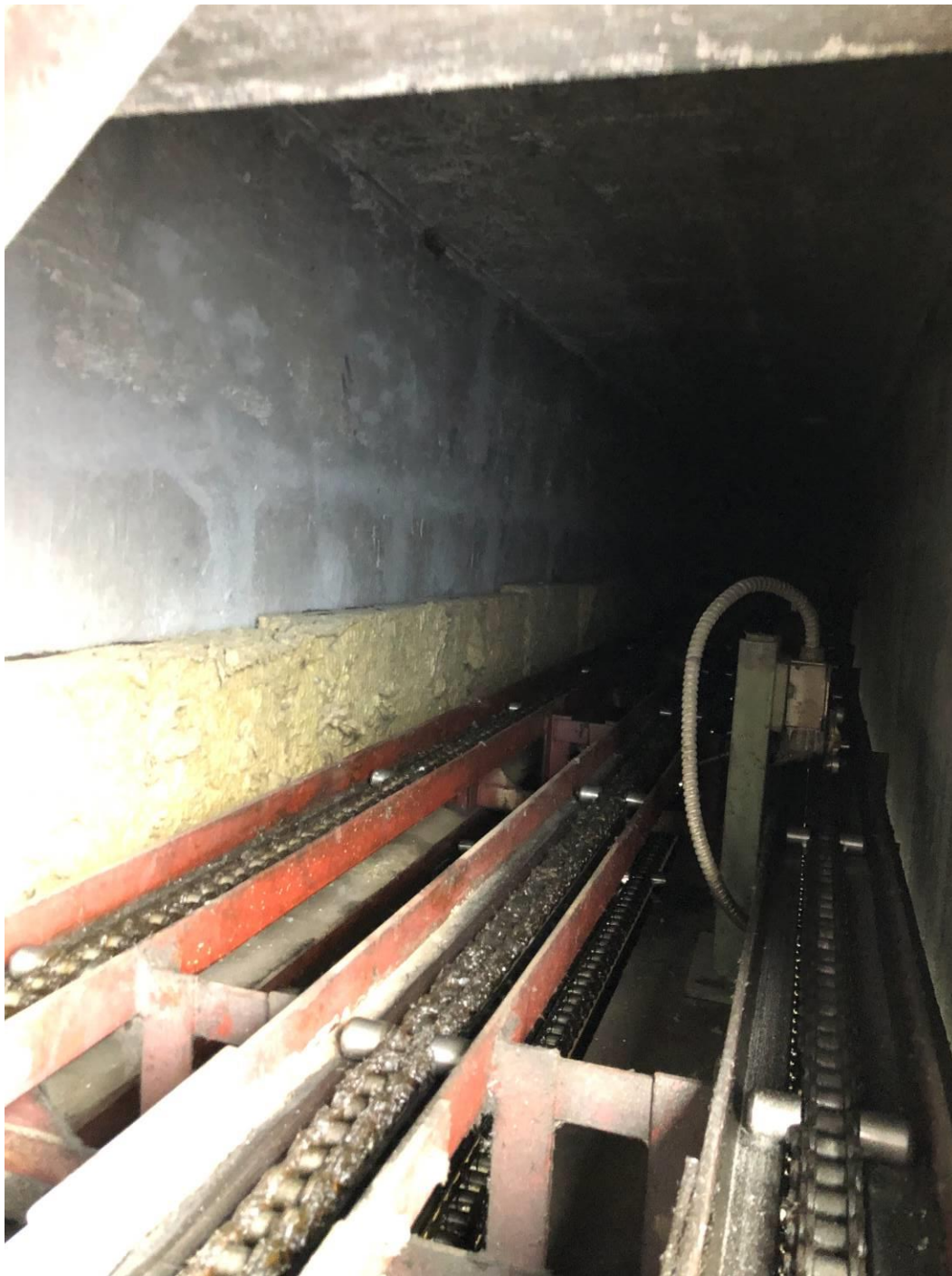
Photo 2 : Rails et chaînes de la porte vus de l'ouverture créer au niveau du toit (Dessin de référence A1-011227-20). Photo prise au niveau du toit ouest, entre le dôme de béton et la poche de béton, en regardant à l'ouest dans le vide de la poche de béton. Notez l'absence de protection contre le feu giclé sur les murs de béton et l'isolant, ne contenant pas d'amiante, installé sur les murs. Les chaînes, rails mécaniques, et les équipements mécaniques associés sont considérés comme étant contaminé avec l'amiante et devons être décontaminé en suivant les protocoles de décontamination de l'amiante. Notez également que le « plancher » solide se termine peu après le poteau de support, avec la majorité du système de rail ouvert au vide de la poche de béton en dessous.
