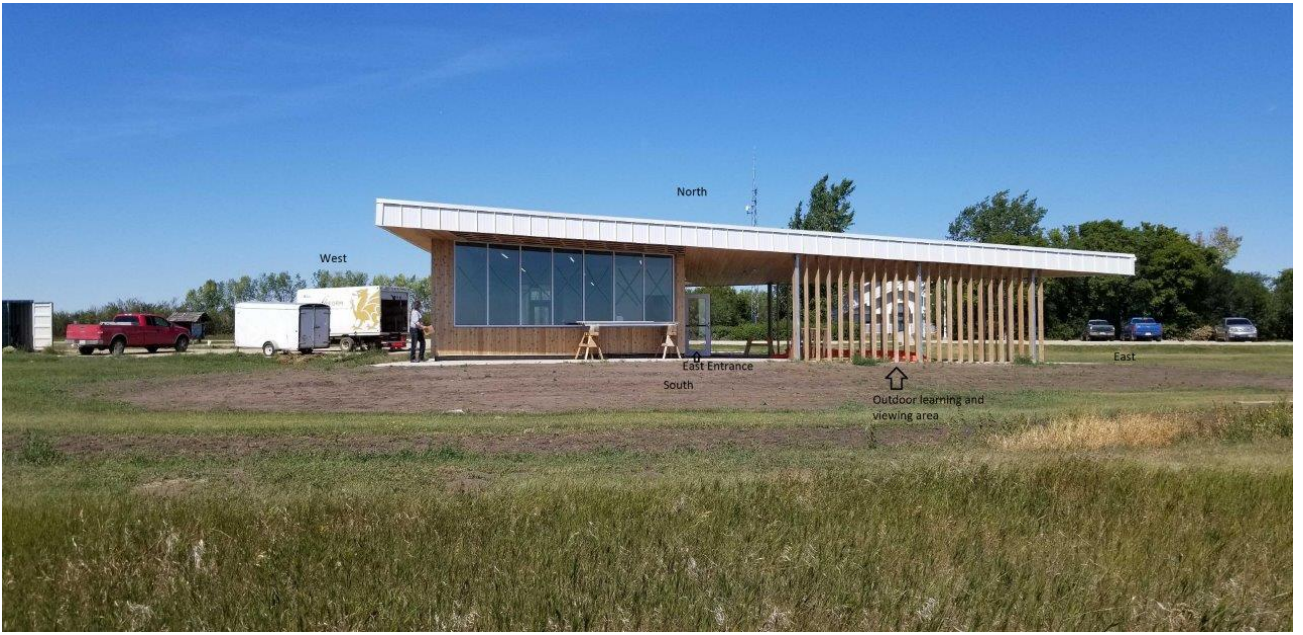
Photo 2 : Pavillon – Vue du sud
