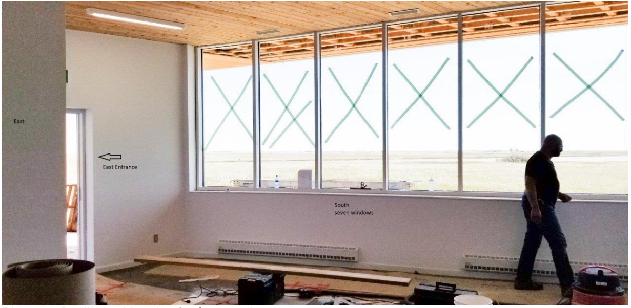
Photo 7 : Pavillon – Vue des fenêtres sud
