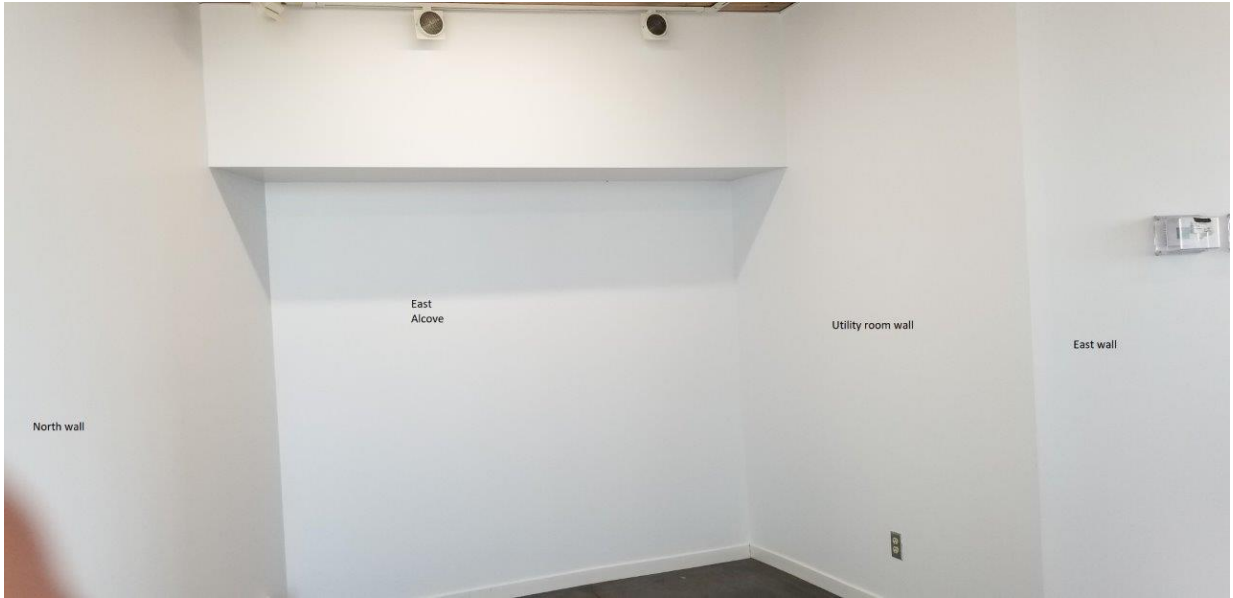
Photo 11 : Pavillon – Alcove du coin nord-est
