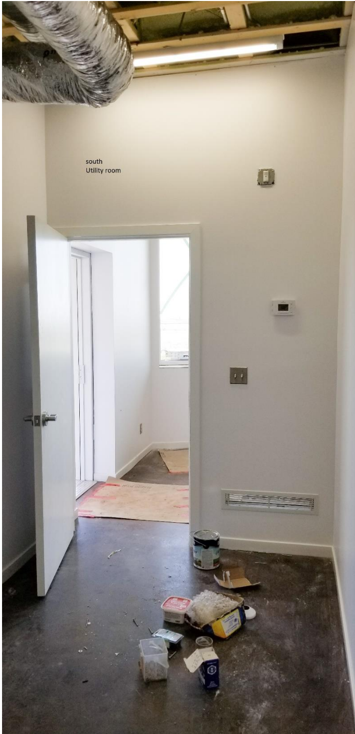
Photo 14 : Pavillon – Pièce de service face au sud
