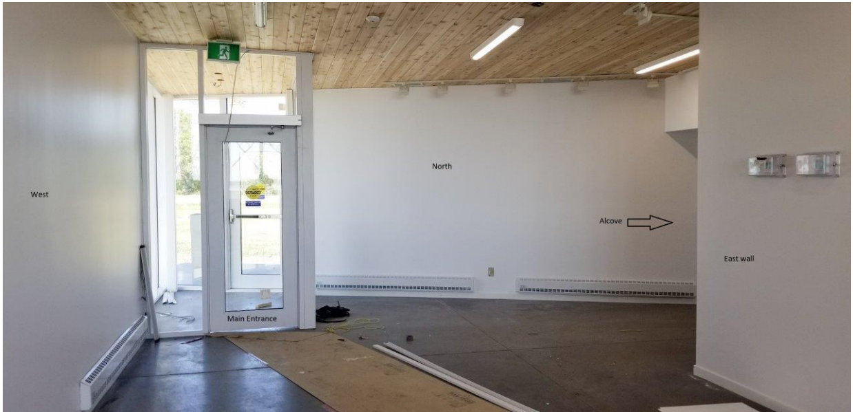
Photo 8 : Pavillon – Vue de la porte principale orientée vers le nord
