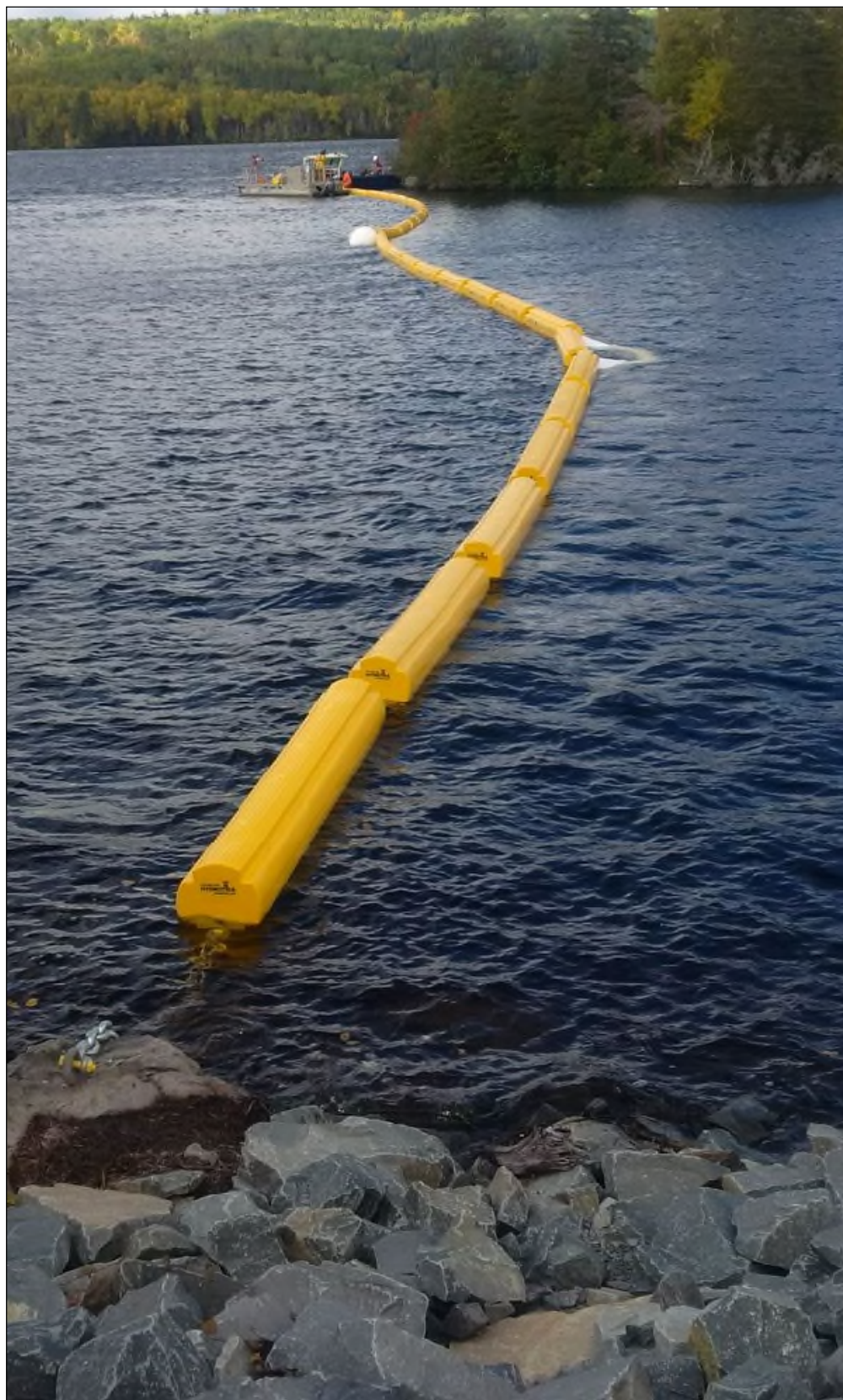
Figure 7 : Barrière de voie navigable actuelle pendant son installation, vue de la rive droite vers la bande de terre.
