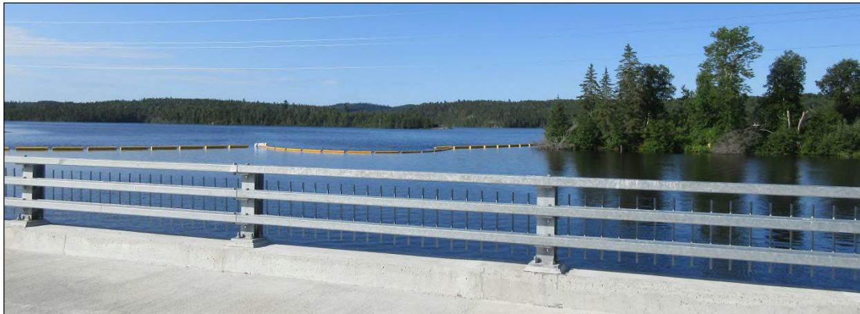
Figure 4 : Barrière de voie navigable actuelle, vue vers l'amont depuis le tablier du barrage de Latchford.
