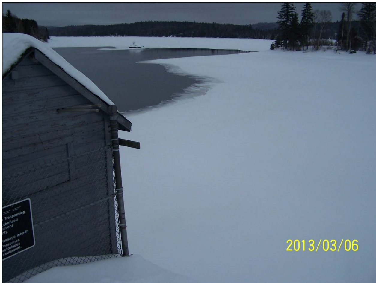
Figure 10 : Conditions de glace en amont du barrage Latchford (normales). La bande de terre sur laquelle l'ancrage gauche est situé est visible dans le coin supérieur droit de la photo.
