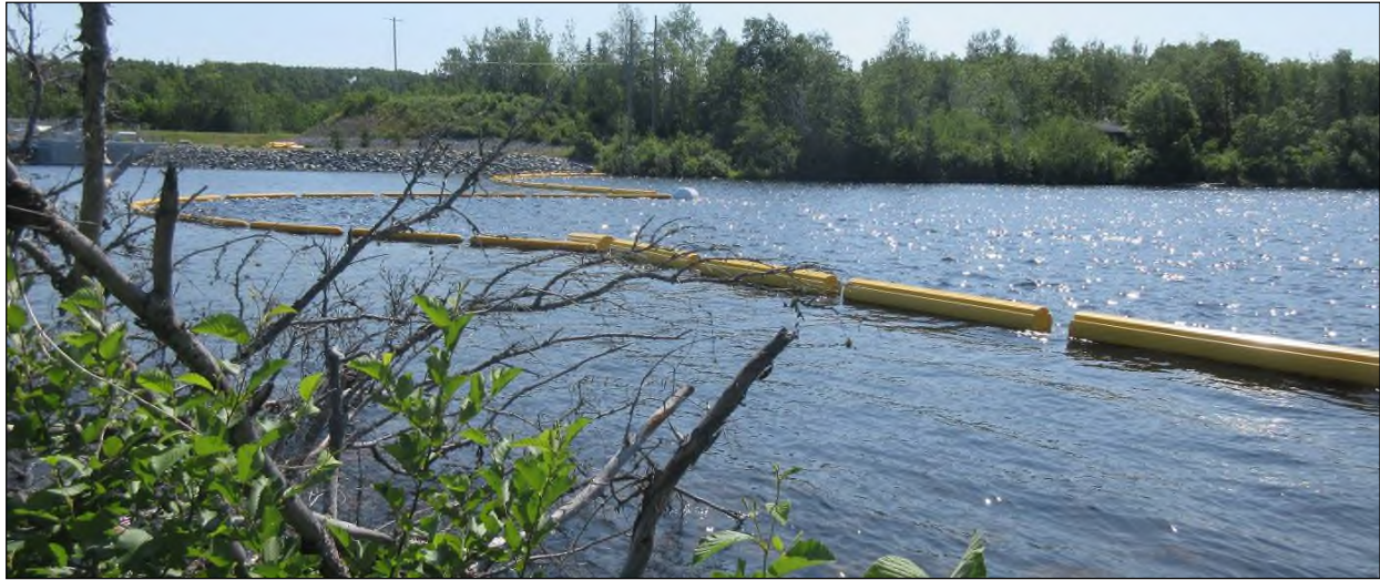
Figure 8 : Barrière de voie navigable actuelle, en position, après avoir été endommagée par la glace. Remarque : la pliure au centre de la photo se trouve à l'endroit de l'épissure entre les anciens flotteurs et les nouveaux installés pour remplacer ceux endommagés (les anciens flotteurs sortent moins de l'eau).
