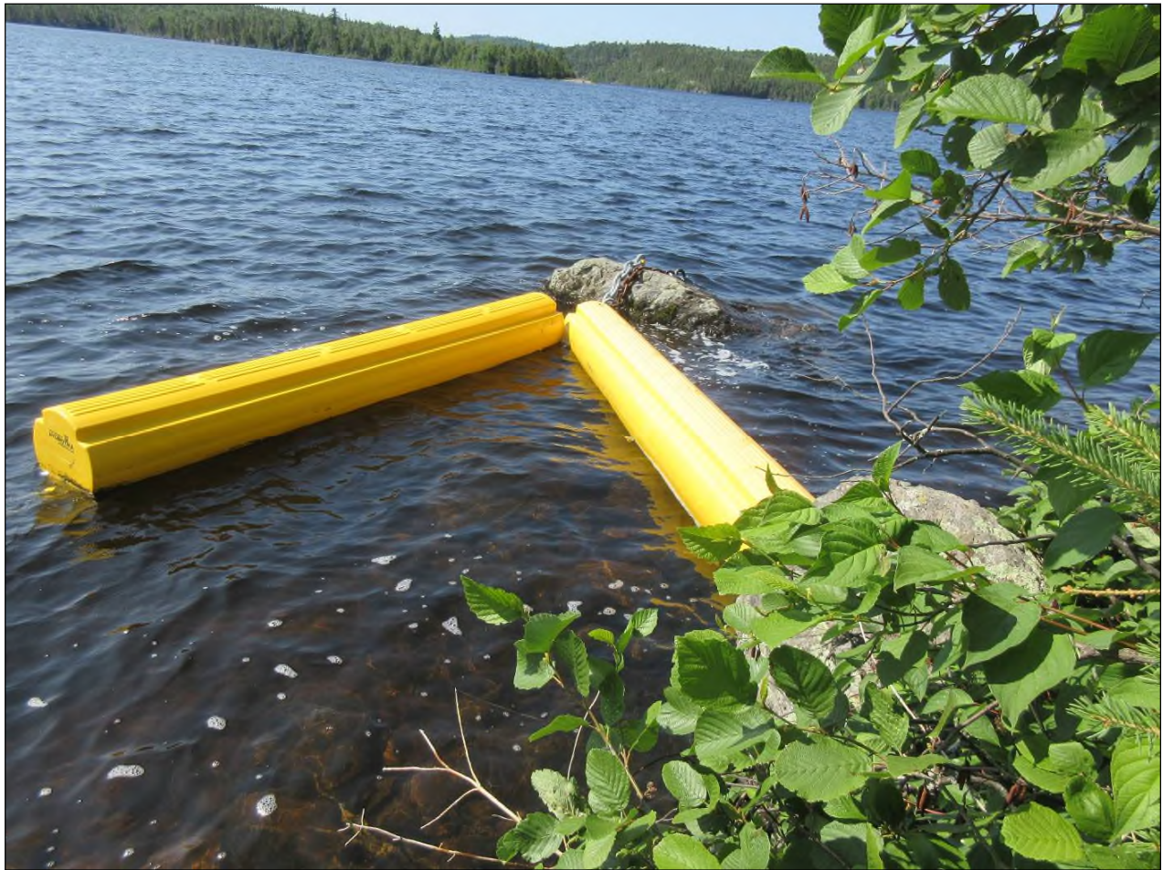
Figure 6 : Gros plan de la barrière de voie navigable dans l'eau, attachée à une roche d'ancrage.
