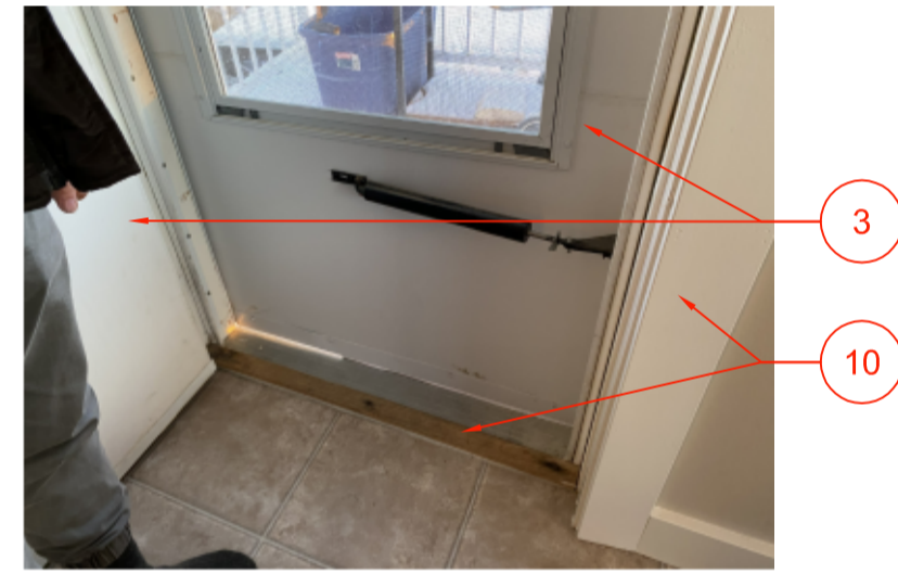
12. MAIN ENTRY DOOR
