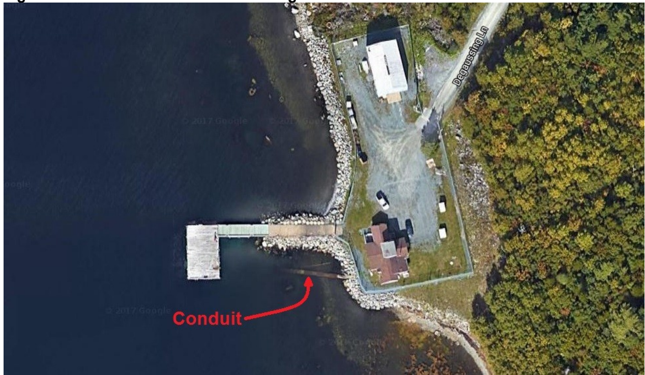
Figure A-2 : Conduit de la station de Wright's Cove
