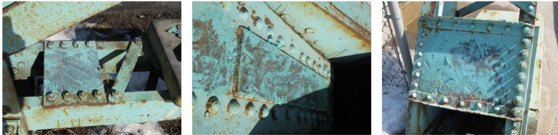
Échantillon après prélèvement (pont ave. St-Pierre/ave. Dollard direction sud) pris depuis les plaques de renfort
