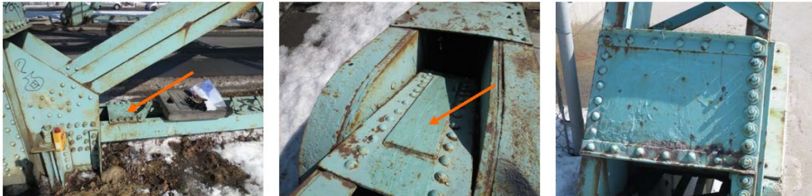
Échantillon avant prélèvement (pont ave. St-Pierre/ave. Dollard direction sud) pris depuis les plaques de renfort
