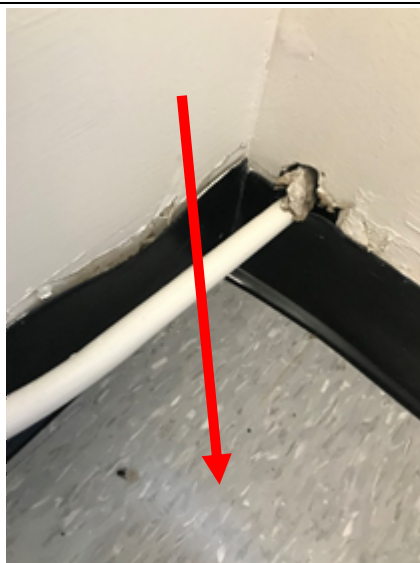
Photo 3: Il a été confirmé que le mastic noir non friable caché sous des carreaux de vinyle de 12 pouces sur 12 pouces avec des rayures grises et blanches observé dans le couloir du 2ème étage, Salle 203, 203A et 204, contient 3% d'amiante chrysotile (échantillon DST 02002246-08A-C). Du mastic noir a également été observé sous le tapis dans la salle 212 et il a été confirmé qu'il contient 3 % d'amiante chrysotile (échantillon DST 02002246.000-10A-C)
