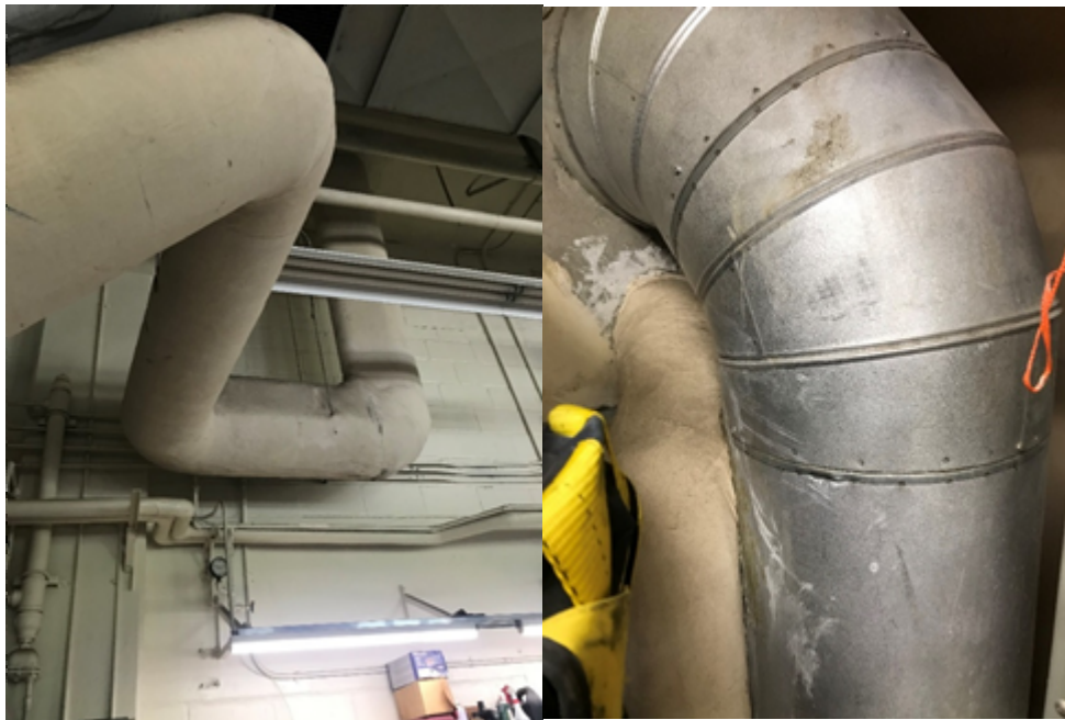
Photo 12 & 13: L'isolation des tuyaux de type 'Aircell' et les raccords de tuyaux isolés ont été observés à l'intérieur de la cage dans la salle 101A sur les conduits d'eau froide potable au niveau du pont. Cette salle était inaccessible au moment de l'enquête.
