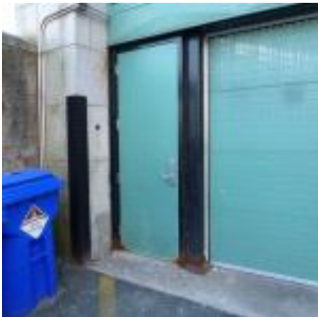
Mars 2016. Présente de rouille à la base de la porte.
