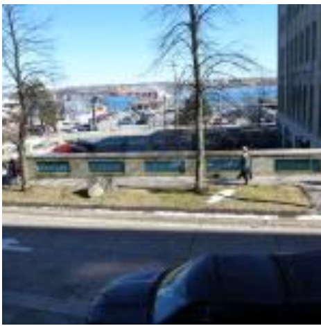
Mars 2016. Mur de soutènement en béton armé et en pierres de granit érigé entre l'aire de stationnement extérieure et la rue Bedford Row.
