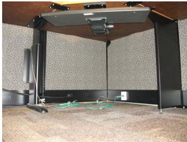
Configuration n° 2 – postes de travail avec des surfaces (généralement deux) qui n'ont pas de surface de travail en coin mais dont une pièce d'angle métallique est ajoutée aux surfaces, créant un angle de 45 degrés. Ces surfaces de travail ne nécessitent aucune modification. Les surfaces de travail doivent être fusionnées pour créer une surface de travail réglable en hauteur d'une seule pièce.
