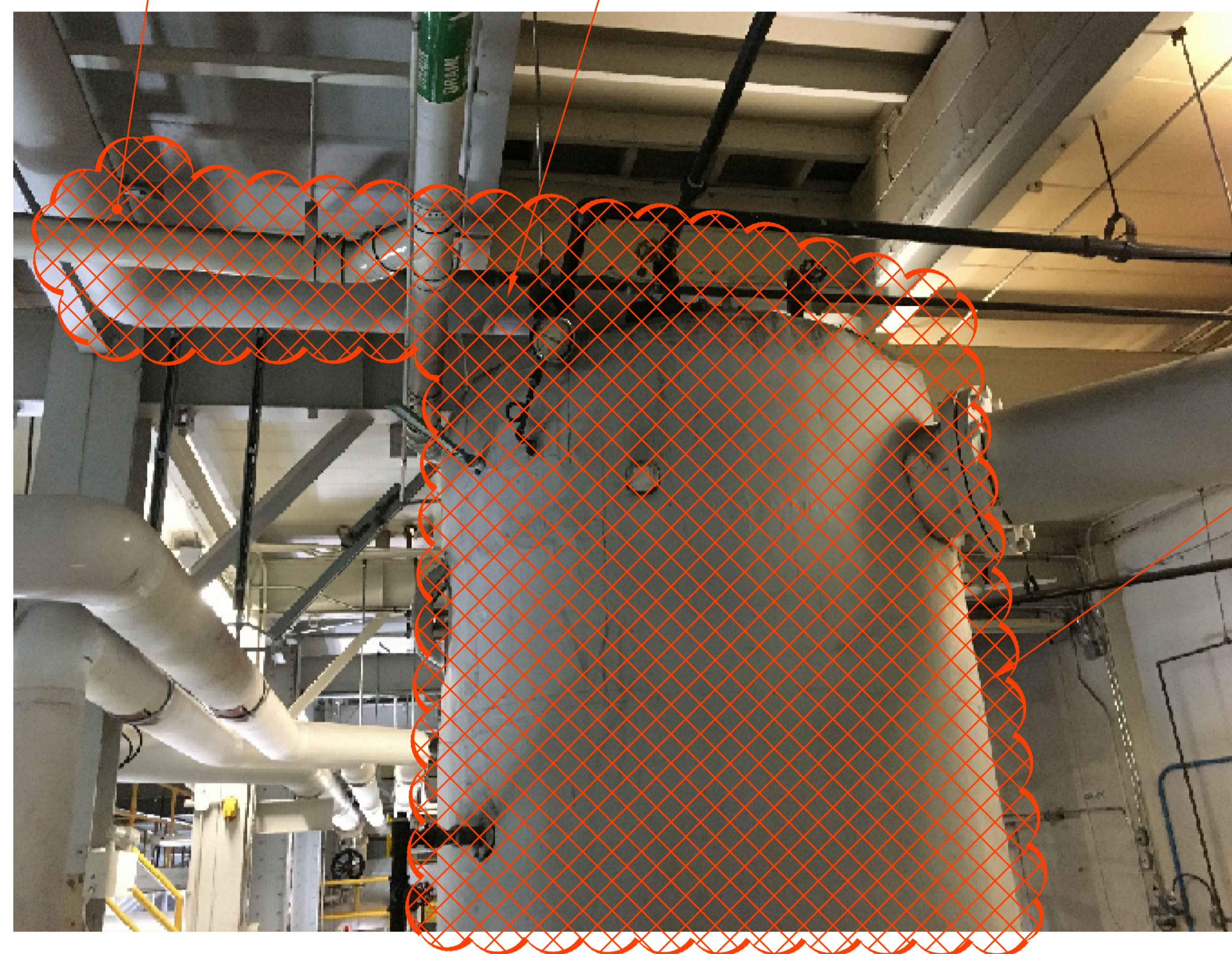
PHOTO 4 : ALIMENTATION D'EAU DU DÉGAZEUR EXISTANT
