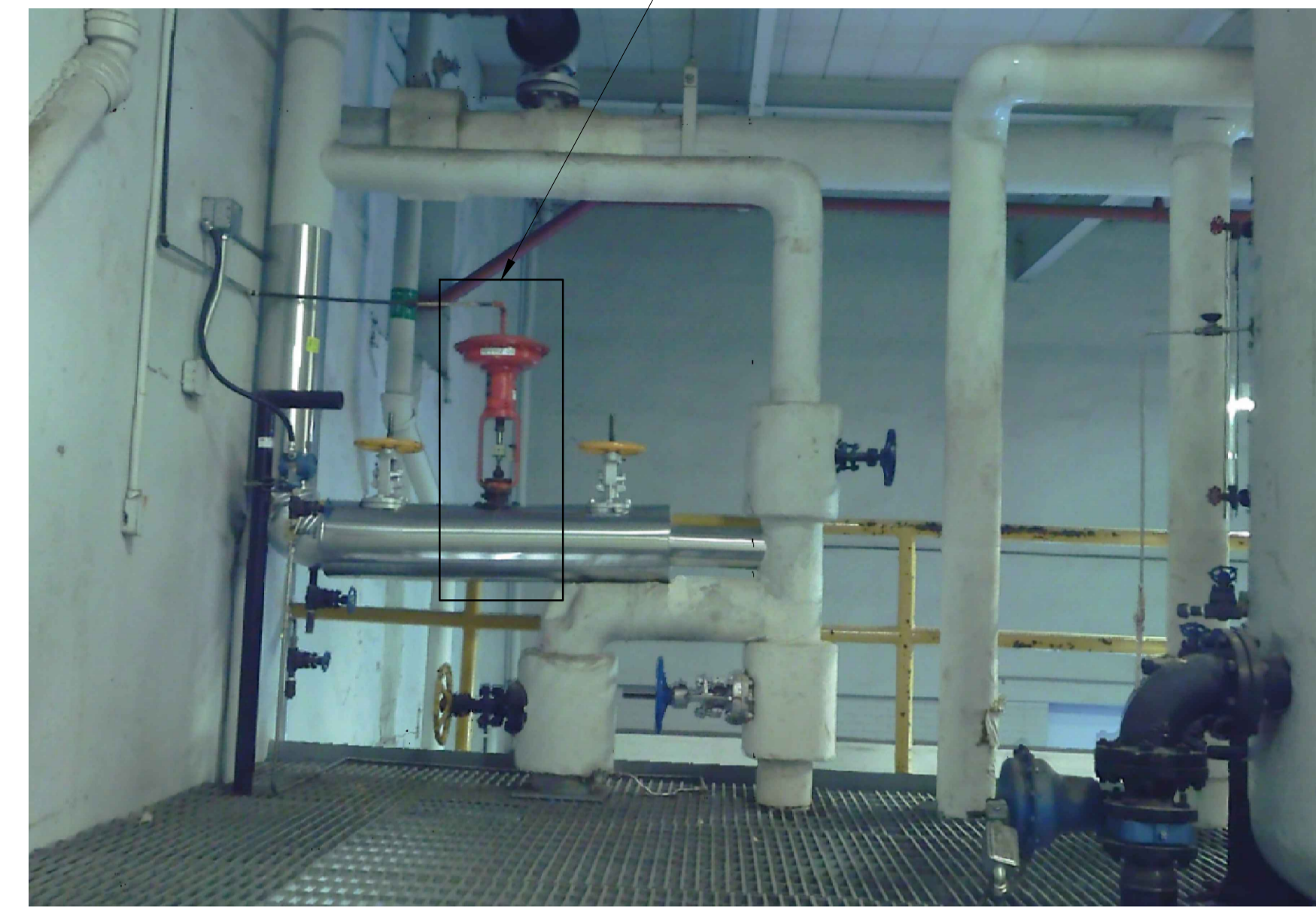
REMPLENER LA VANNE D'ALIMENTATION EN EAU. REMPLACER TOUS LES JOINTS AVANT LE REMONTAGE
