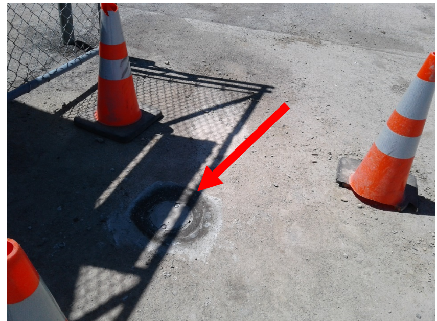
PHOTO 16 Réfection de la surface du puits d'observation 2019-P02
