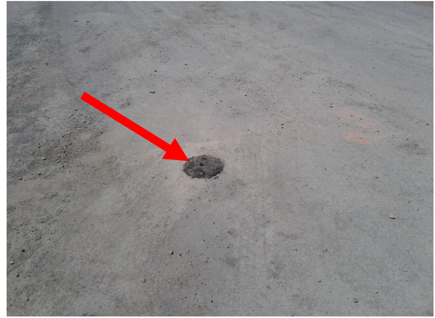
PHOTO 14 Réfection de la surface du puits d'échantillonnage 2019-PE12
