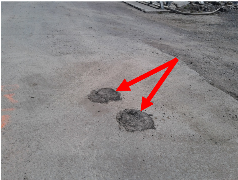
PHOTO 15 Réfection de la surface du puits d'échantillonnage 2019-PE13 Le forage a été déplacé car un objet a été détecté par Mine/EOD
