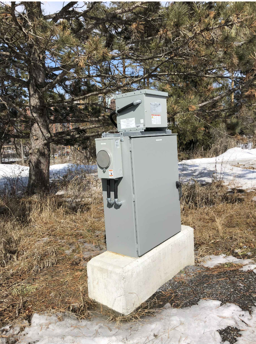
3 EXISTING PARKING LIGHTING METER CABINET SCALE: N.T.S.
