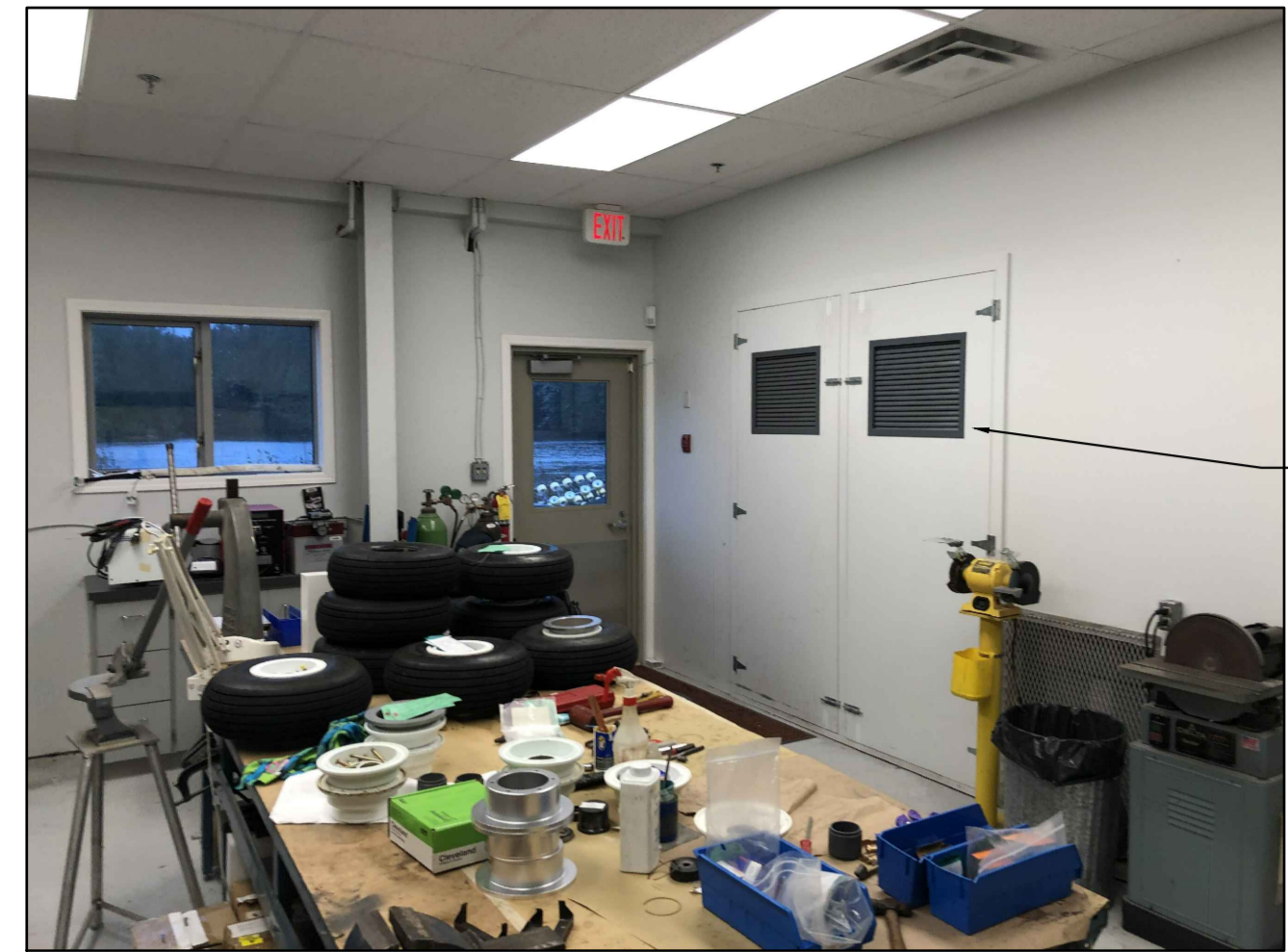
2 IMAGE 2 - ELECTRICAL CLOSET SCALE: N.T.S.
