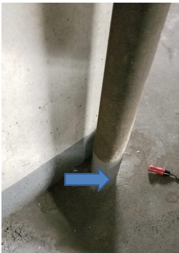
Photo 2. Composé de ciment ne contenant pas d'amiante près d'une colonne. Le composé de ciment est appliqué à la truelle au bas du tuyau.
