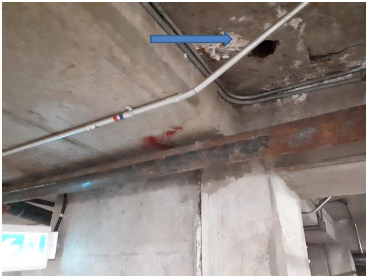
Photo 1. Crépi-ciment ne contenant pas d'amiante près d'un ancien tuyau de drainage.
