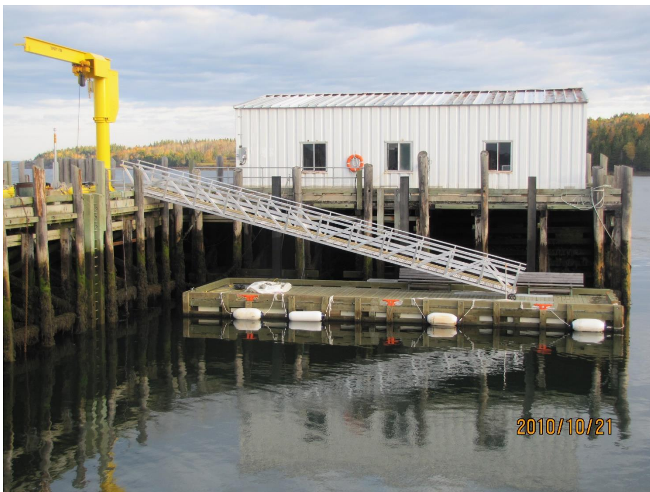
Ponton et de la passerelle de la Station biologique de St. Andrews
