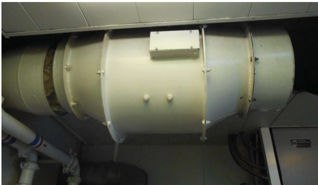
Figure 16.3-6 : Photographie du ventilateur axial d'alimentation du groupe électrogène de secours (SF-9)
