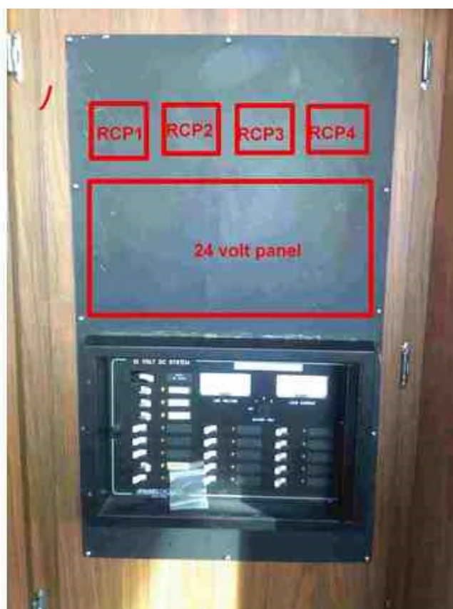
Figure 17.4-21 : Emplacement proposé du système de distribution de 24 V et du panneau de commande à distance
