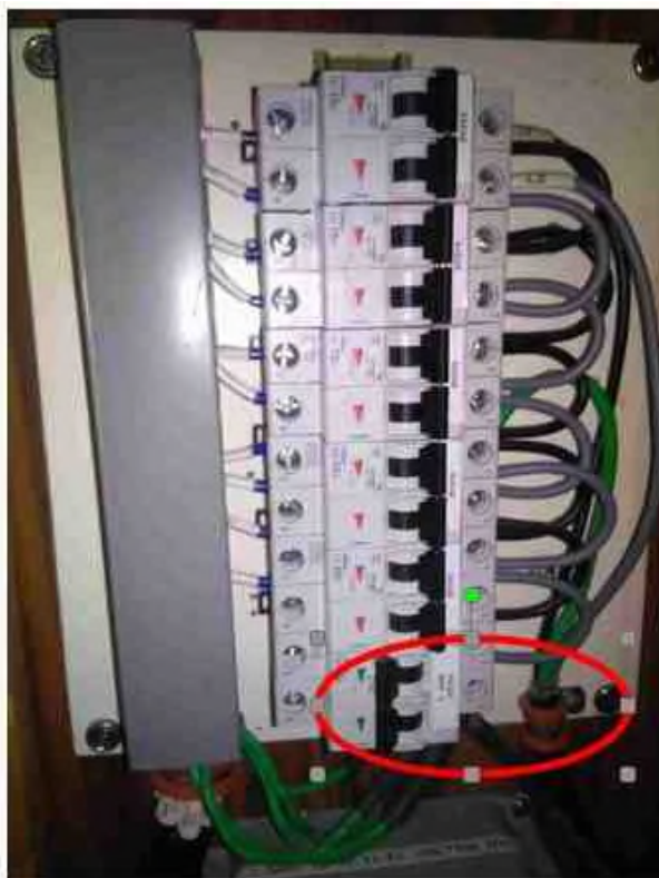
Figure 17.4-26 : Disjoncteur de l'ASC du radar
