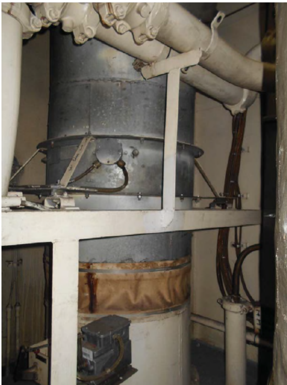
Figure 16.3-2 : Photographie du ventilateur axial d'évacuation de la salle des machines (EF-7 ou EF-8)
