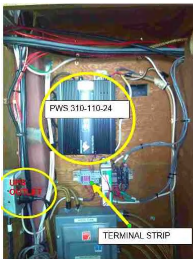
Figure 17.4-4 : Source d'alimentation de 24 V – Tableau
