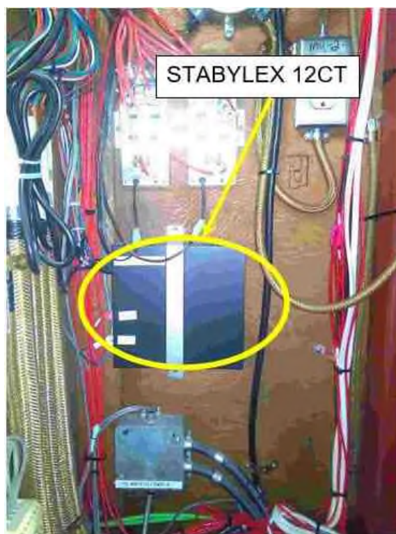
Figure 17.4-1 : Emplacement de la source d'alimentation Stabylex
