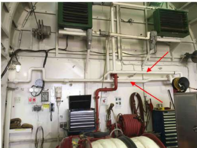
8 Matériau contenant de l'amiante Embarcations — Hangar d'hélicoptère — Tuyauterie — Eau chaude — Magnésie — Bon — N/A Chantal.Soulard - 2020-06-29 14:04
