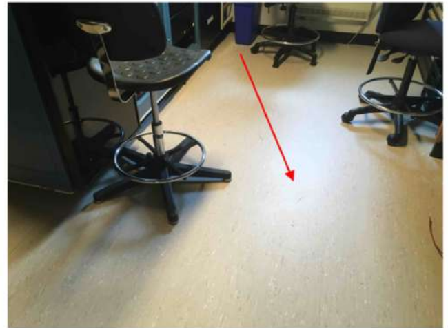
57 Matériau contenant de l'amiante Embarcations — Local 308 (contrôles électriques) — Plancher — Tuile de vinyle et colle — 12" x 12" — Remplacé — N/A Chantal.Soulard - 2020-06-29 14:01
