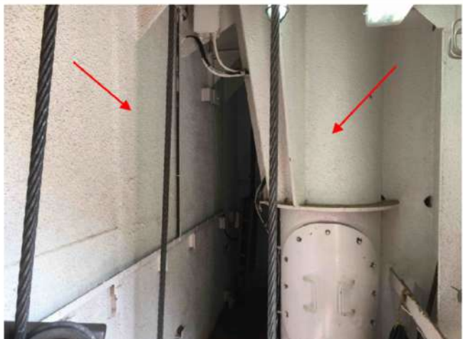
26 Matériau contenant de l'amiante Principal — Local 114 — Mur — Revêtement texturé — Bon — N/A Chantal.Soulard - 2020-06-29 15:43
