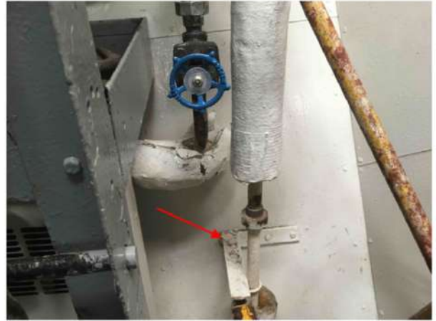
16 Matériau contenant de l'amiante Principal — Local 100 (magasin du maître d'équipage) — Tuyauterie — Eau chaude — Magnésie — Passable — N/A Chantal.Soulard - 2020-06-29 15:05 Debris à nettoyer
