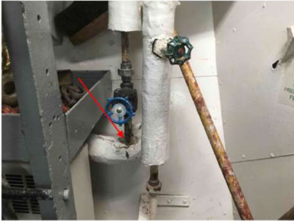
16 Matériau contenant de l'amiante Principal — Local 100 (magasin du maître d'équipage) — Tuyauterie — Eau chaude — Magnésie — Passable — N/A Chantal.Soulard - 2020-06-29 15:05 Coude à remplacer
