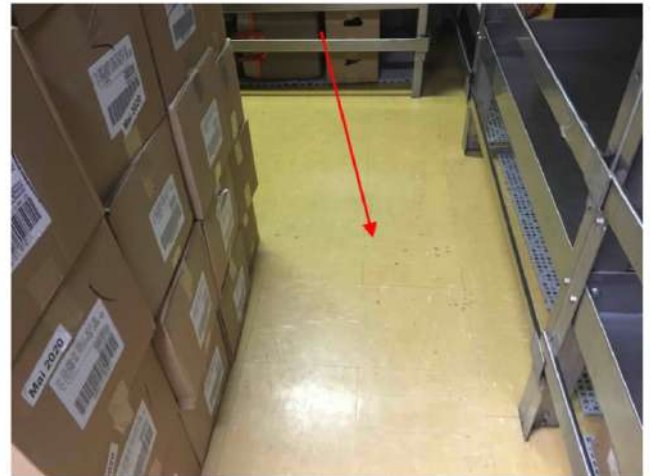
28 Matériau contenant de l'amiante Principal — Local 116 (magasin des vivres secs) — Plancher — Tuile de vinyle et colle — 12" x 12" — Bon — N/A Chantal.Soulard - 2020-06-29 15:33
