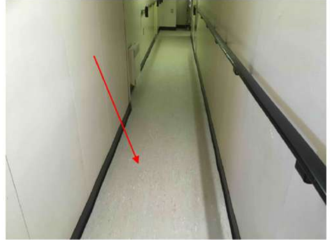
58 Matériau contenant de l'amiante Embarcations — Corridor — Plancher — Tuile de vinyle et colle — 12" x 12" — Remplacé — N/A Chantal.Soulard - 2020-06-29 13:58
