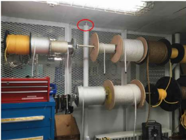
36 Matériau contenant de l'amiante Principal — Local 166 (magasin de cordages) — Tuyauterie — Eau chaude (retour) — Magnésie — Passable — N/A Chantal.Soulard - 2020-06-29 16:06 Extrémité à sceller
