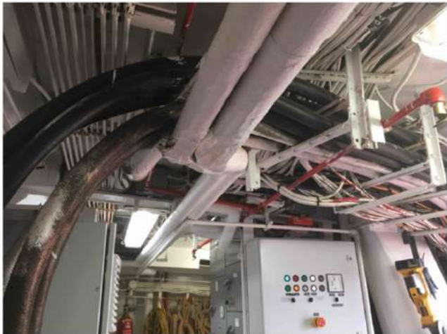
20 Matériau contenant de l'amiante Principal — Local 101 (salle des treuils) — Tuyauterie — Eau chaude (retour) — Magnésie — Bon — N/A Chantal.Soulard - 2020-06-29 16:13
