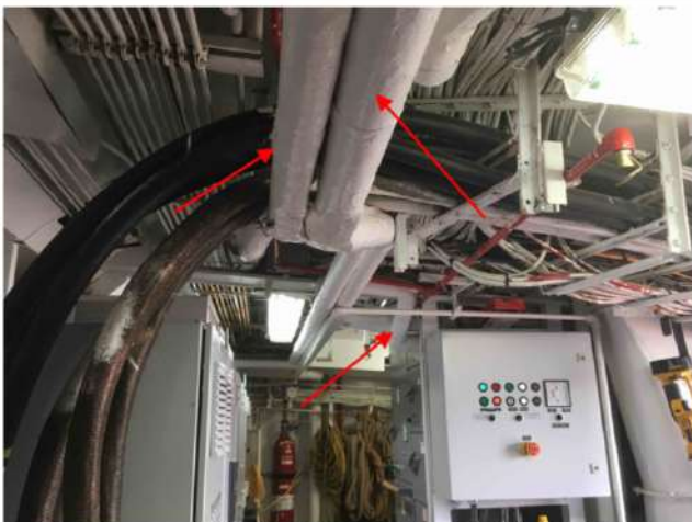
19 Matériau contenant de l'amiante Principal — Local 101 (salle des treuils) — Tuyauterie — Eau chaude — Magnésie — Bon — N/A Chantal.Soulard - 2020-06-29 15:40
