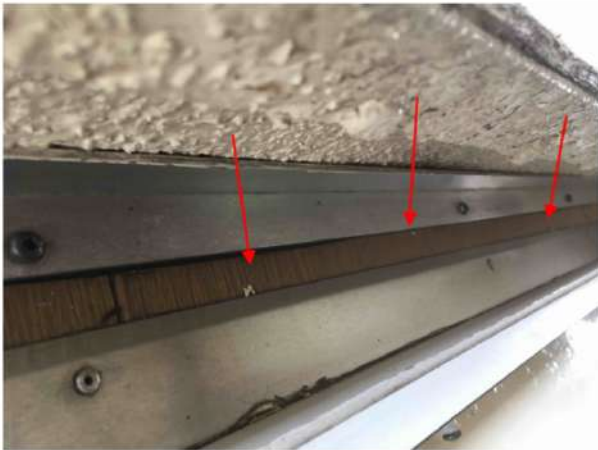
1 Matériau contenant de l'amiante Timonerie — Local 501 — Cadre de fenêtre — , — Revêtement texturé — Quelques débris à nettoyer — N/A Chantal.Soulard - 2020-06-29 13:37
