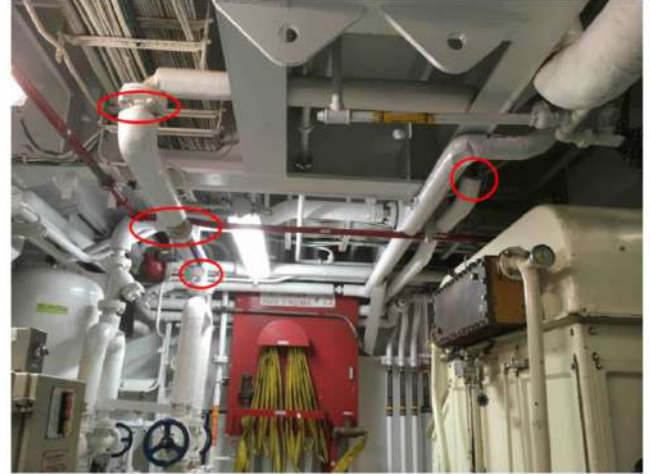
45 Matériau contenant de l'amiante Moteurs — Salle des moteurs principaux — Tuyauterie — Eau chaude — Magnésie — Bon — N/A Chantal.Soulard - 2020-06-29 16:49
