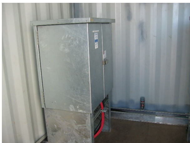
Redresseurs R2, R4 et R5-7 installés dans le conteneur électrique.
