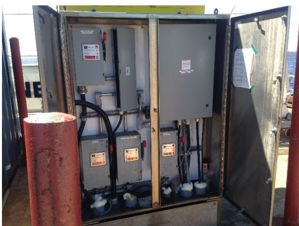
Panneau électrique (AC) et RMU.
