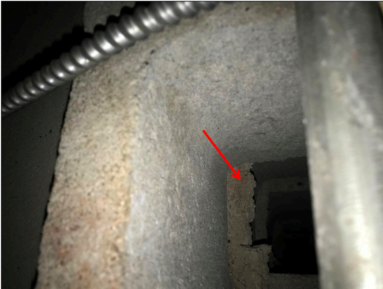
Photo 6 – Vue d'un possible matériau contenant de la vermicrete à l'intérieur d'un bloc de cendres
