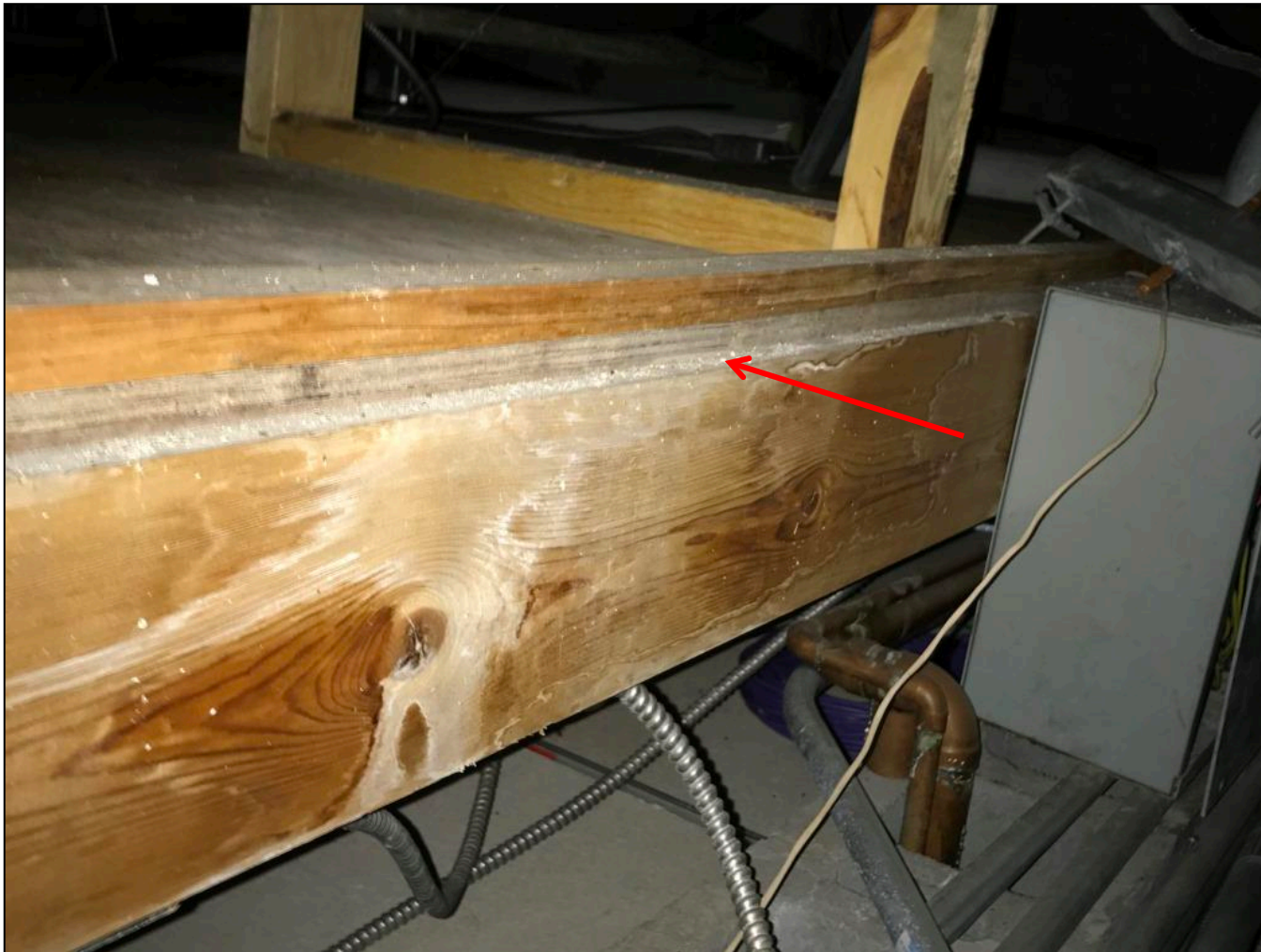
Photo 5 – Vue de petites quantités de débris de mortier et/ou vermicrete sur une étagère en bois, au-dessus des tuiles de plafond (salle 106)
