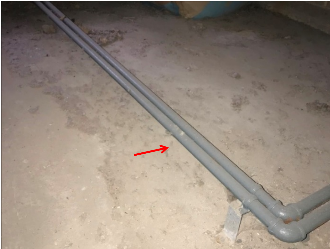
Photo 1: Rez-de-chaussée, Salle 112 – Peinture grise (contenant du plomb)
