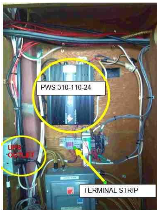
Figure 17.4-4 : Source d'alimentation de 24 V – Tableau
