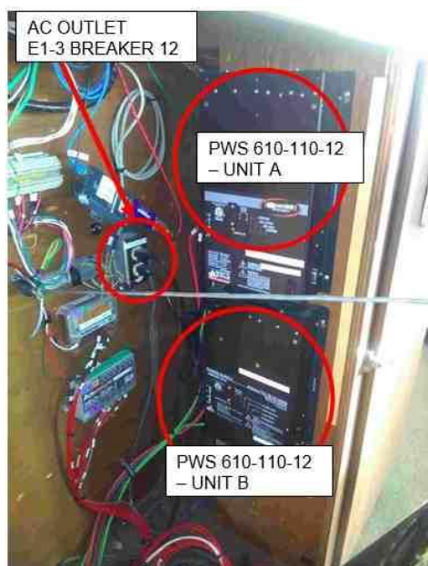
Figure 17.4-16 : Emplacement actuel des sources d'alimentation de 12 V
