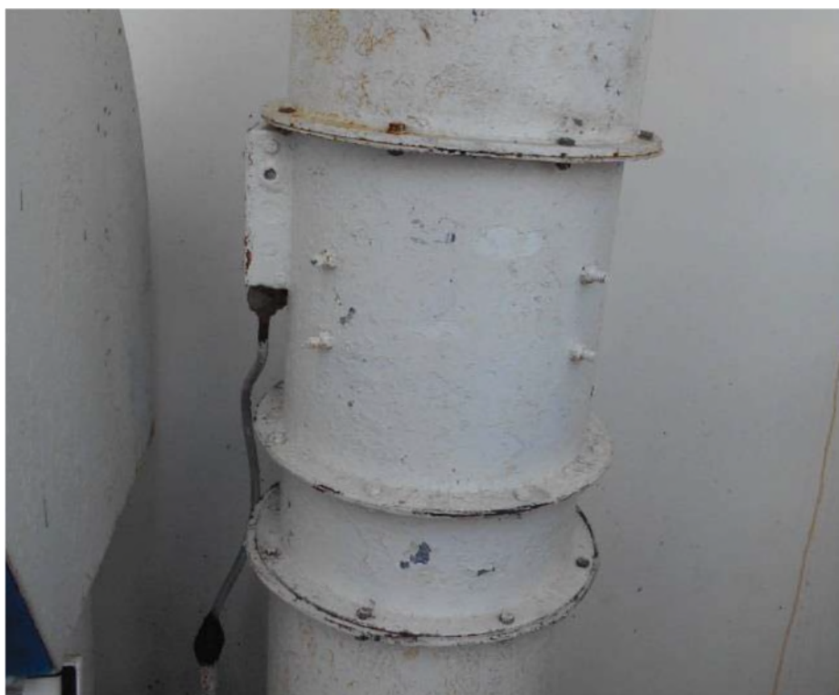
Figure 16.3-8 : Photographie du ventilateur axial d'évacuation de la cuisine – installé sur le pont découvert (EF-2)
