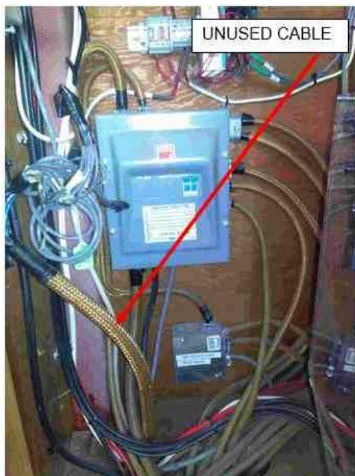
Figure 17.4-18 : Câble qu'on doit enlever
