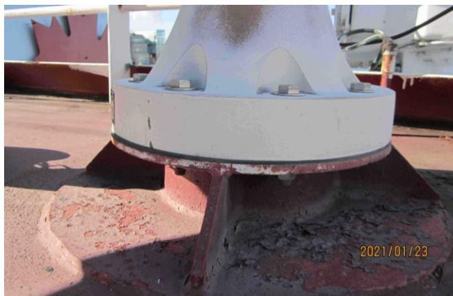
Figure 17.3-5 : Base de l'antenne VALCOM à TRIBORD
