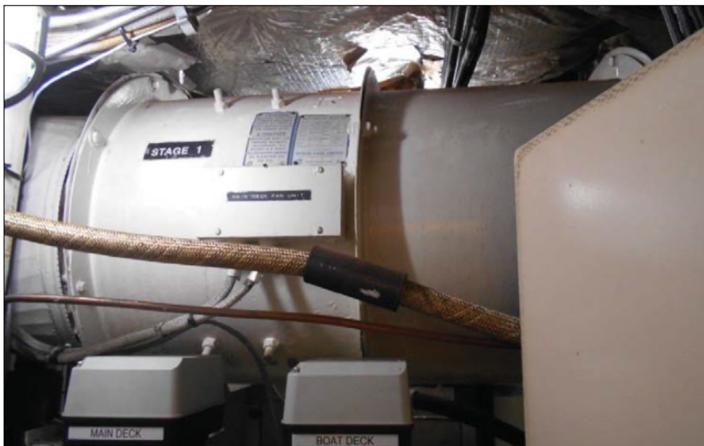
Figure 16.3-4 : Photographie du ventilateur axial d'alimentation du pont principal (SF-3)
