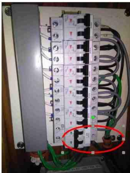
Figure 17.4-26 : Disjoncteur de l'ASC du radar
