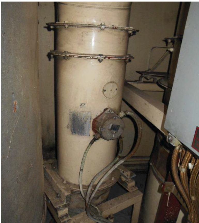
Figure 16.3-10 : Photographie du ventilateur axial d'alimentation de la salle de commande des machines (SF-4)
