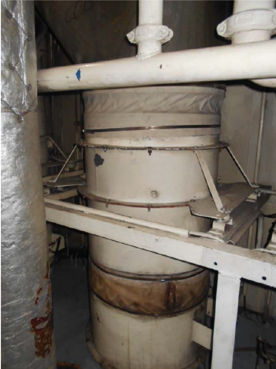
Figure 16.3-1 : Photographie du ventilateur d'alimentation dans la salle des machines (SF-7 ou SF-8)
