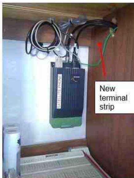
Figure 17.4-25 : Émetteur-récepteur Iridium
