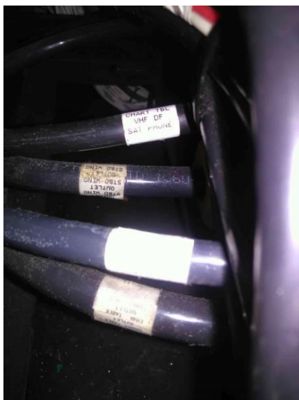
Figure 17.4-13 : Câbles de sortie de l'ASC
