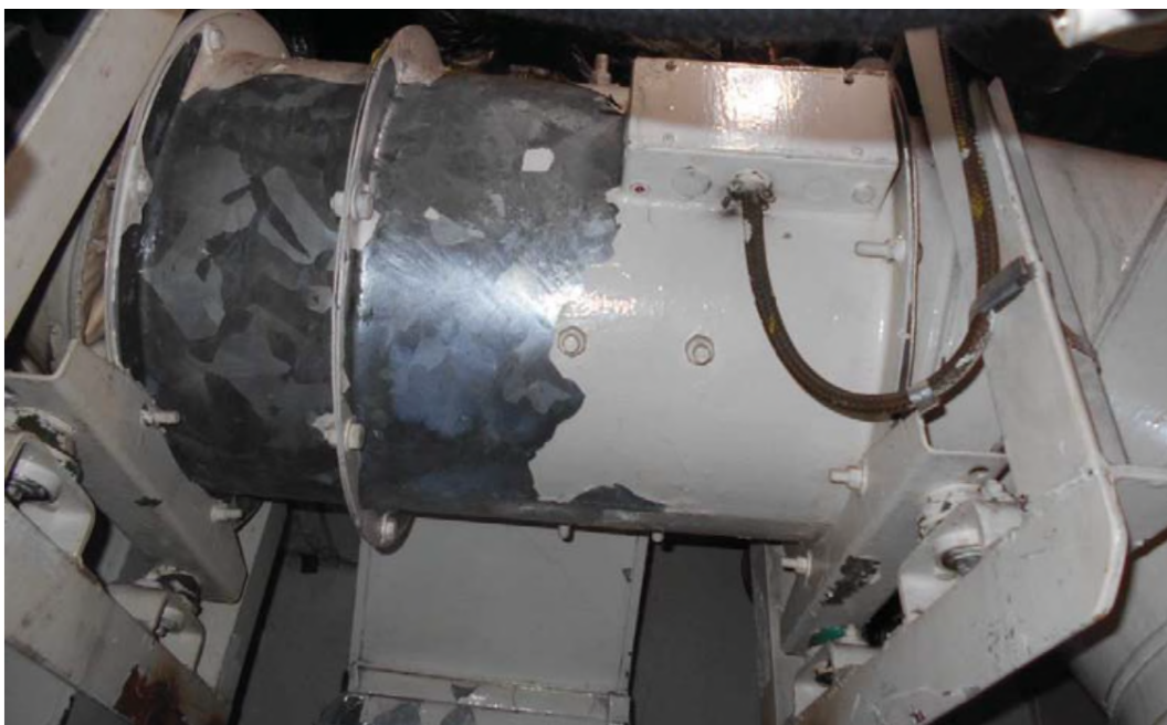
Figure 16.7 : Photographie du ventilateur axial d'alimentation du pont de gaillard (SF-1)
