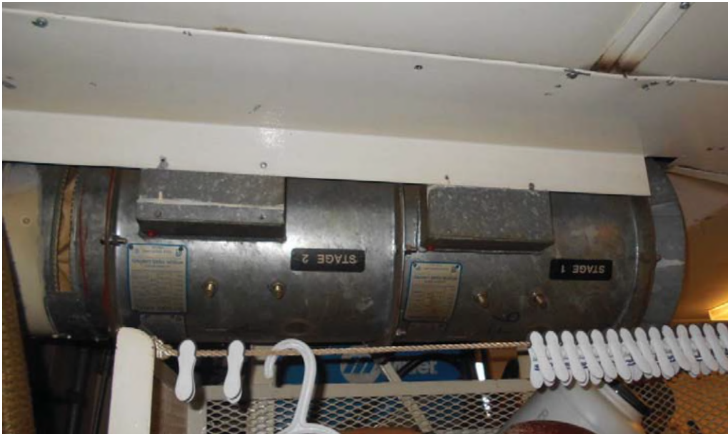
Figure 16.3-9 : Photographie des ventilateurs axiaux d'alimentation de l'atelier du pont (SF-6.1 & SF-6.2)
