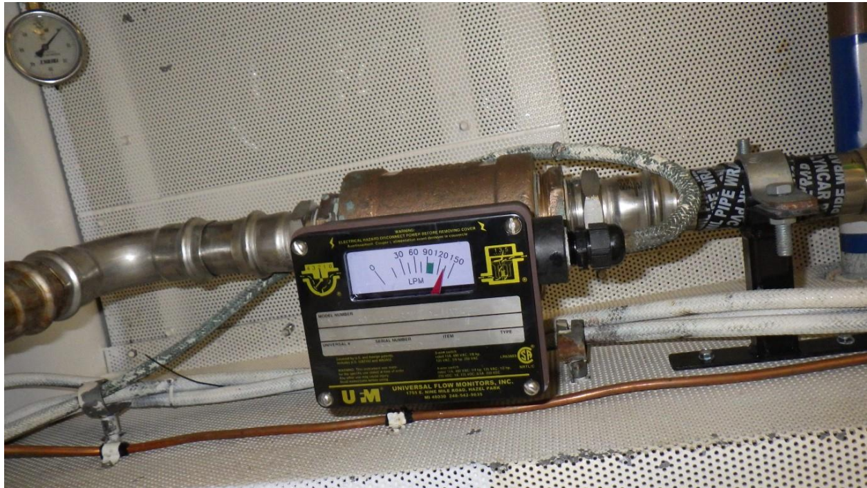
Exemple d'installation des nouveaux débitmètres
