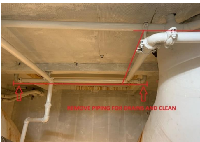
Drain du placard à joint plastique ci-dessus
