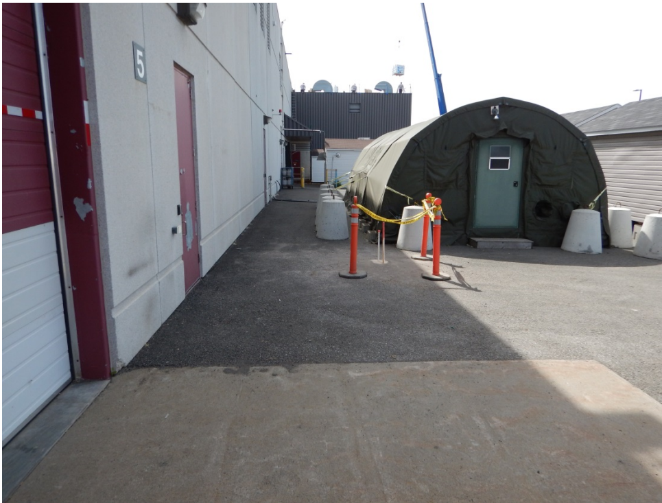
Photo 3 : Emplacement du forage F-15-03 et vue du piézomètre installé
