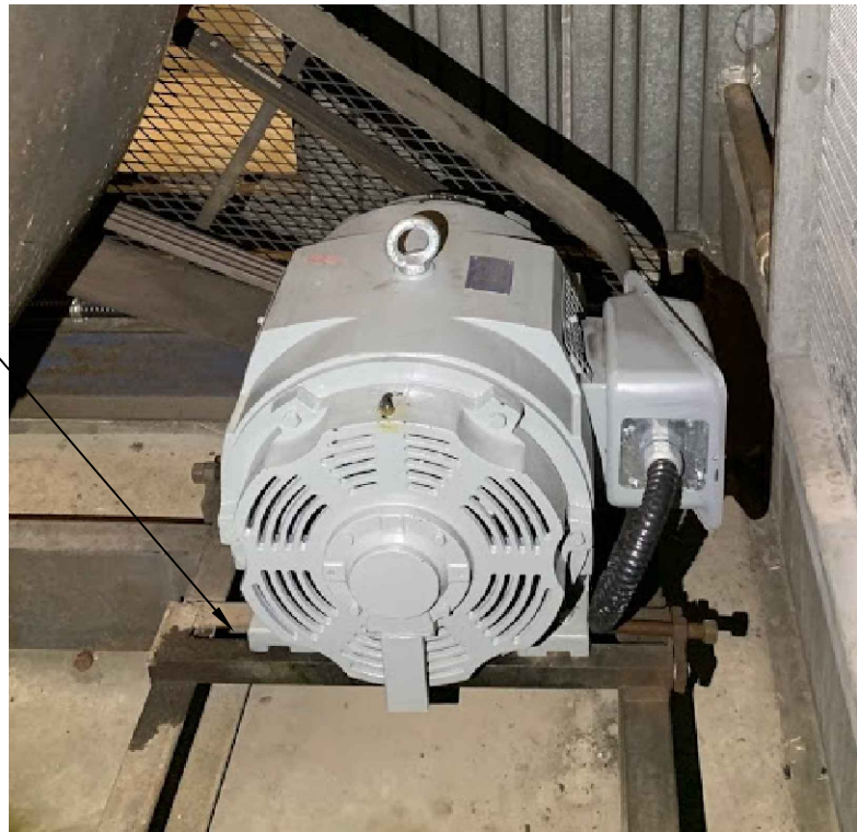
MOTEUR DU VENTILATEUR D'ALIMENTATION
