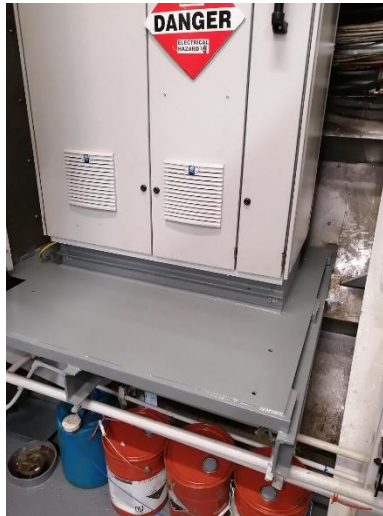
Installation actuelle du filtre passif ABB tribord, du siège et de la plaque de base
