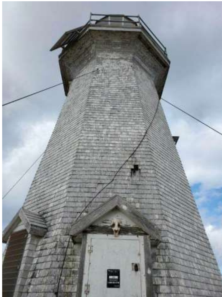
Ancrage des hauban sur le phare et parement de bois du phare
