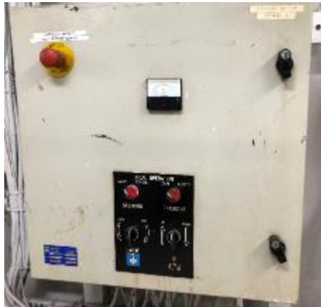
Armoire de commande du propulseur arrière (compartiment du propulseur arrière)
