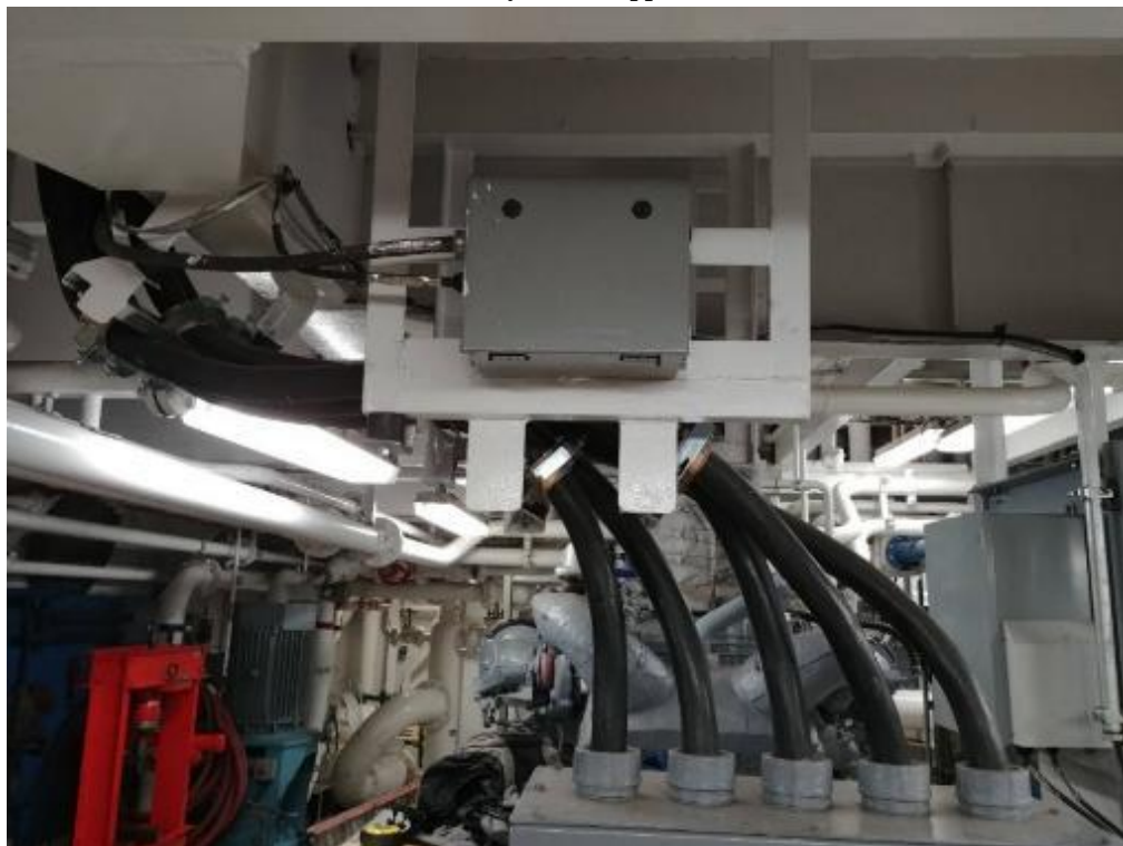
Photo 4: DA1 - Conduits de ventilation et tuyau d'échappement
