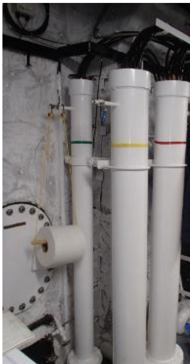
Photo 14 - Isolation derrière conduit
