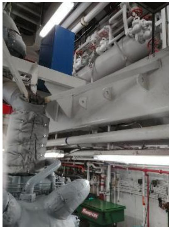
Photo 7: DA3 - Œillets, réservoir d'expansion, tuyau d'échappement et supports
