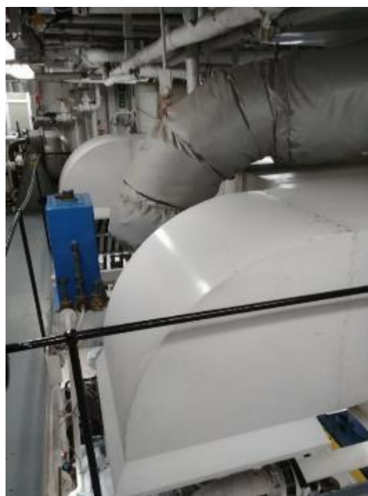
Photo 9: DA3 - Conduit de ventilation et tuyau d'échappement
