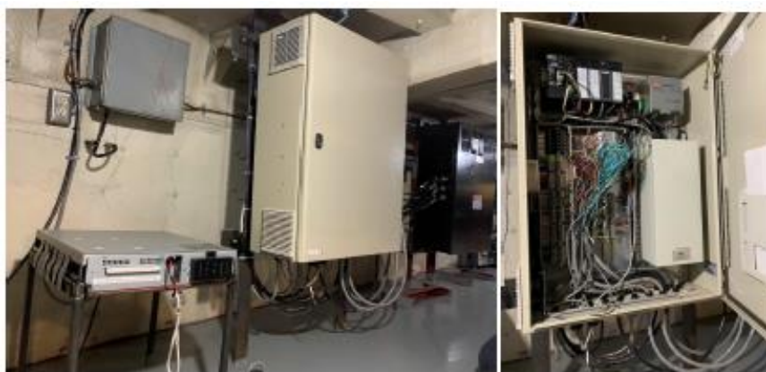
Armoires de commande du propulseur de la galerie de la timonerie
