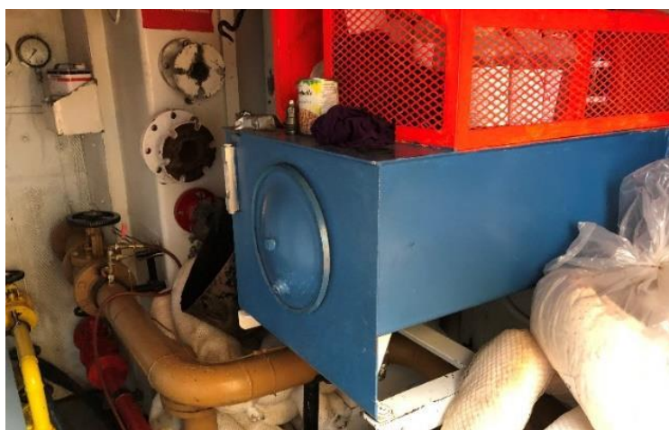
Collecteur de tête pour l'huile avant (salle de commande des vannes de la station de pompage avant)
