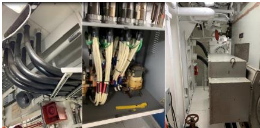
Câblage du moteur à partir du VFD, boîte de filtre, moteur électrique avant
