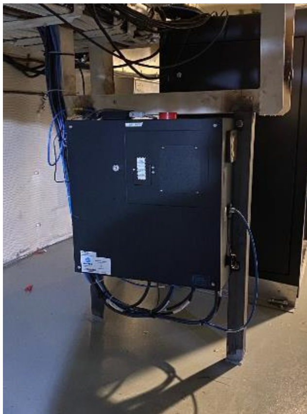
Figure 4 Unité de traitement des données SVDR existante à retirer et à remplacer par la nouvelle unité d'acquisition de données
