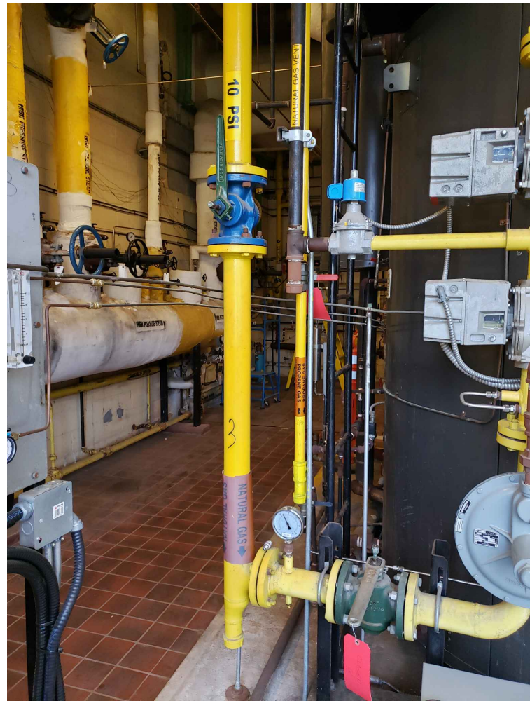
C M101 CONNEXION GAZ NATUREL SCALE:N.T.S.
