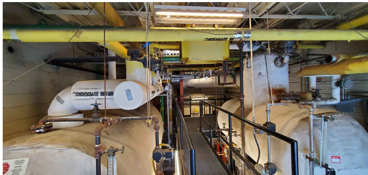
D M101 COLLECTEUR DE CONDENSATION SCALE:N.T.S.
