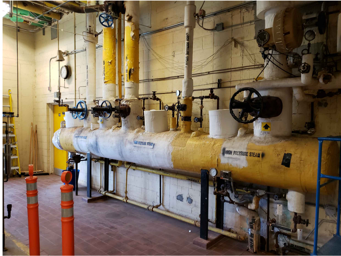
B M101 COLLECTEUR DE VAPEUR DE CHAUDIÈRE SCALE:N.T.S.
